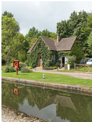
Vue de la maison éclusière. Phot. Pierre-Marie Barbe-Richaud IVR26_20175800279NUC2A
