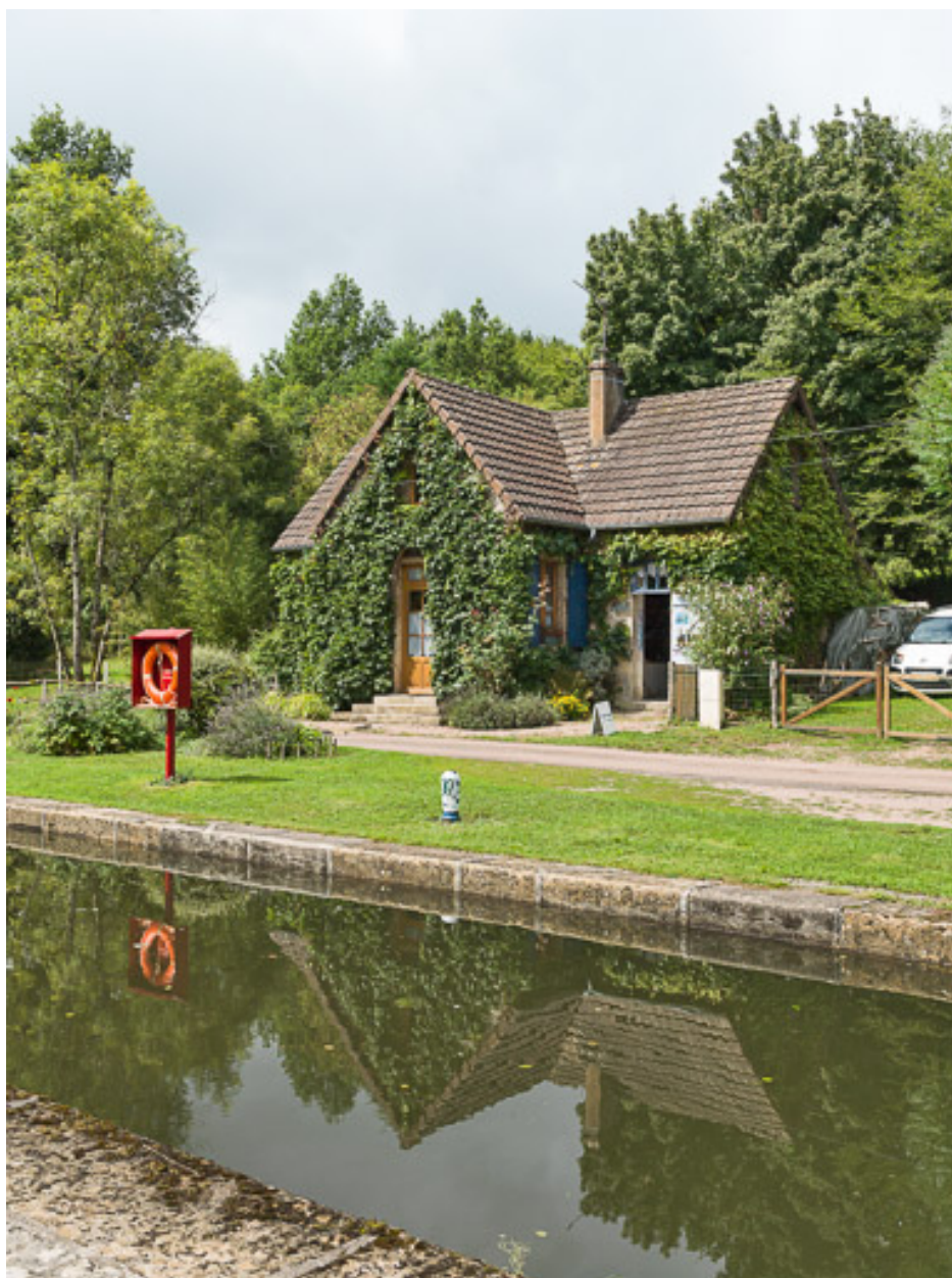
Vue de la maison éclusière.
