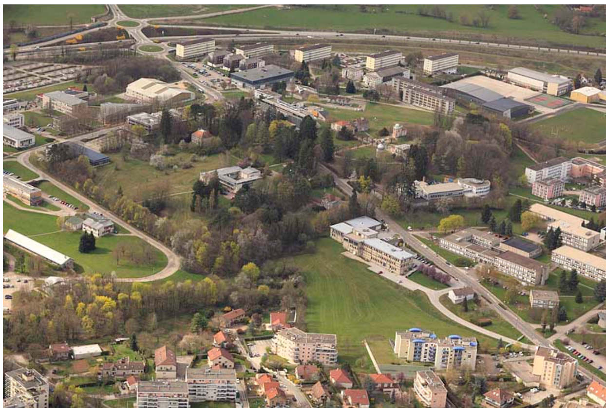
Vue aérienne du site, depuis le sud-est.
