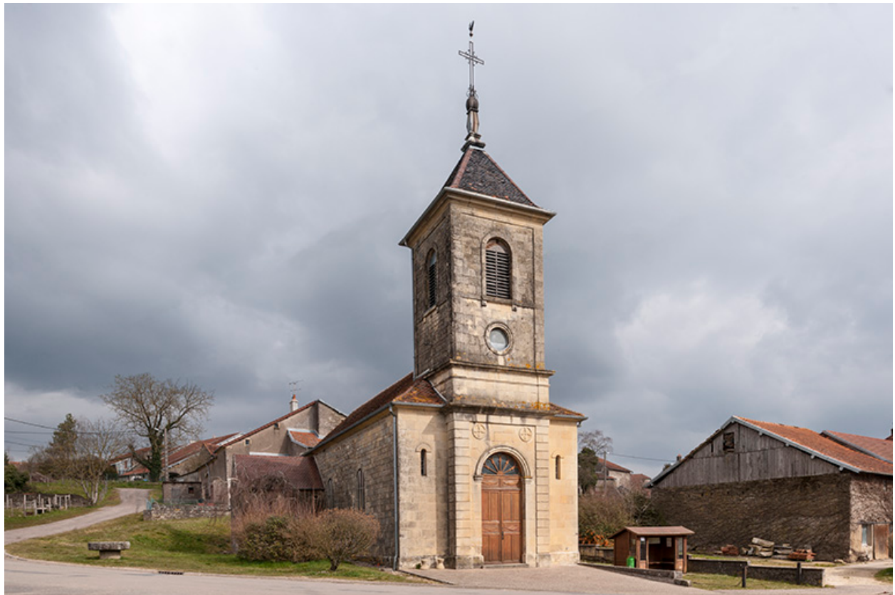
L'église et le bâti présent autour.
