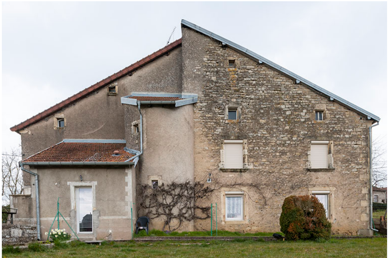
détail sur la maison avec tourelle.
