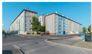
Bâtiments E et I, façades antérieures et latérales. Phot. Thierry Kuntz IVR26_20155800042NUC4A
