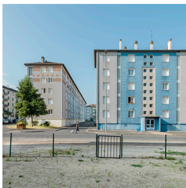
Bâtiment E, façades latérale et postérieure ; bâtiment I façade antérieure. Phot. Thierry Kuntz IVR26_20155800047NUC4A
