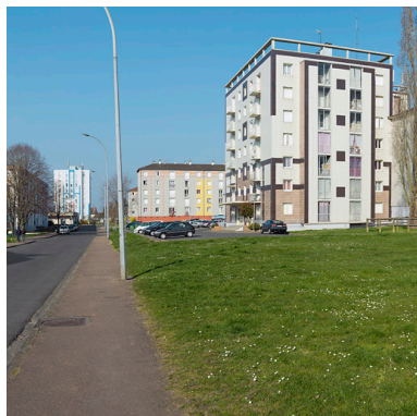
Vue générale depuis la rue du Berry en direction du nord, au premier plan le bloc G. Phot. Thierry Kuntz IVR26_20145800009NUC4A
