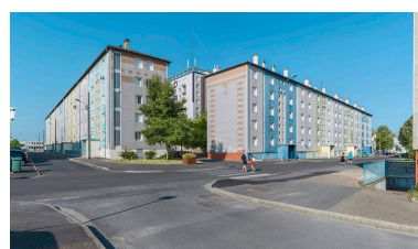
Bâtiments E et I, façades antérieures et latérales. Phot. Thierry Kuntz IVR26_20155800041NUC4A
