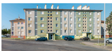
Bâtiment A, façade antérieure est. Phot. Thierry Kuntz IVR26_20155800050NUC4A
