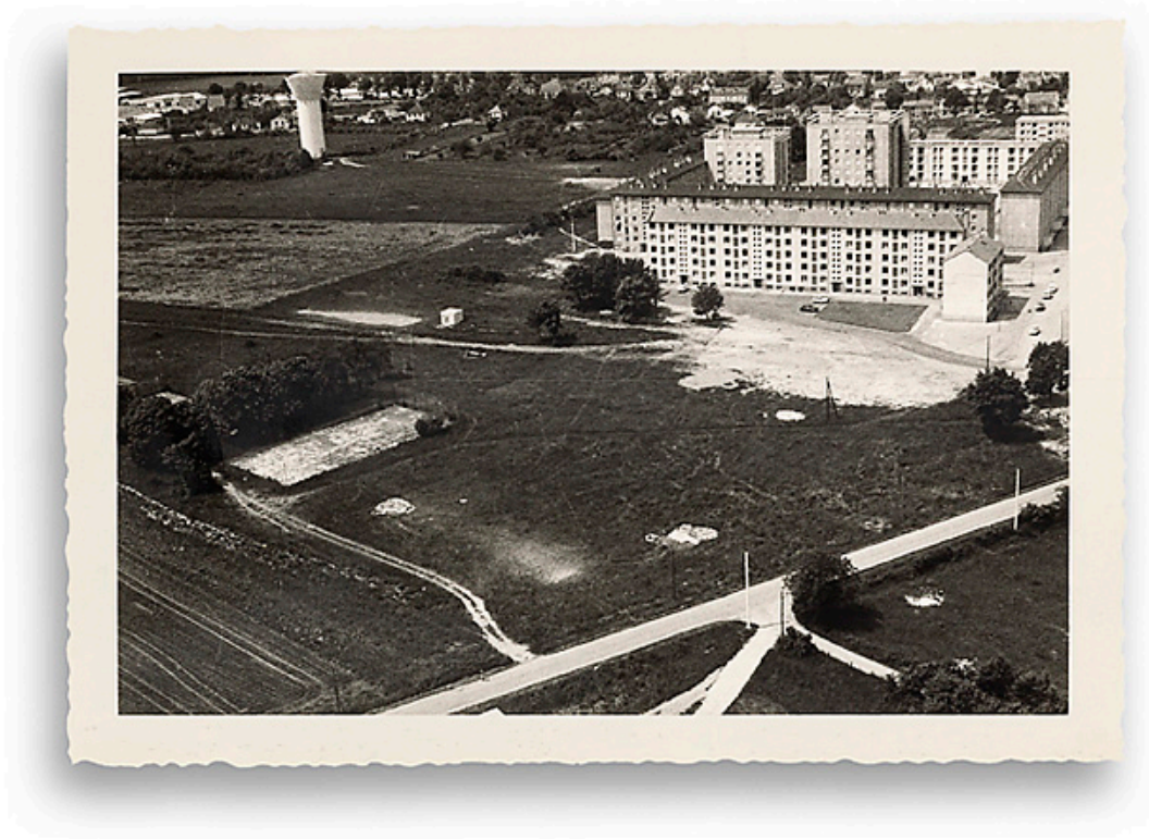
Vue aérienne du quartier Saint-Laurent en construction. Photographie ancienne, s.d., [1970-1971]. (Archives municipales Cosne-Cours-sur-Loire, 202W683 - 2Fi76)
