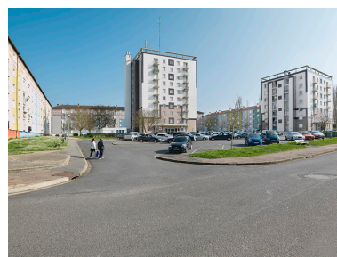
Bâtiments I, E , F et blocs H et G depuis la rue du Berry.
