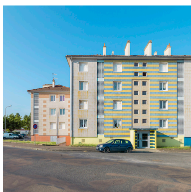
Bâtiment A, façade antérieure. Phot. Thierry Kuntz IVR26_20155800051NUC4A
