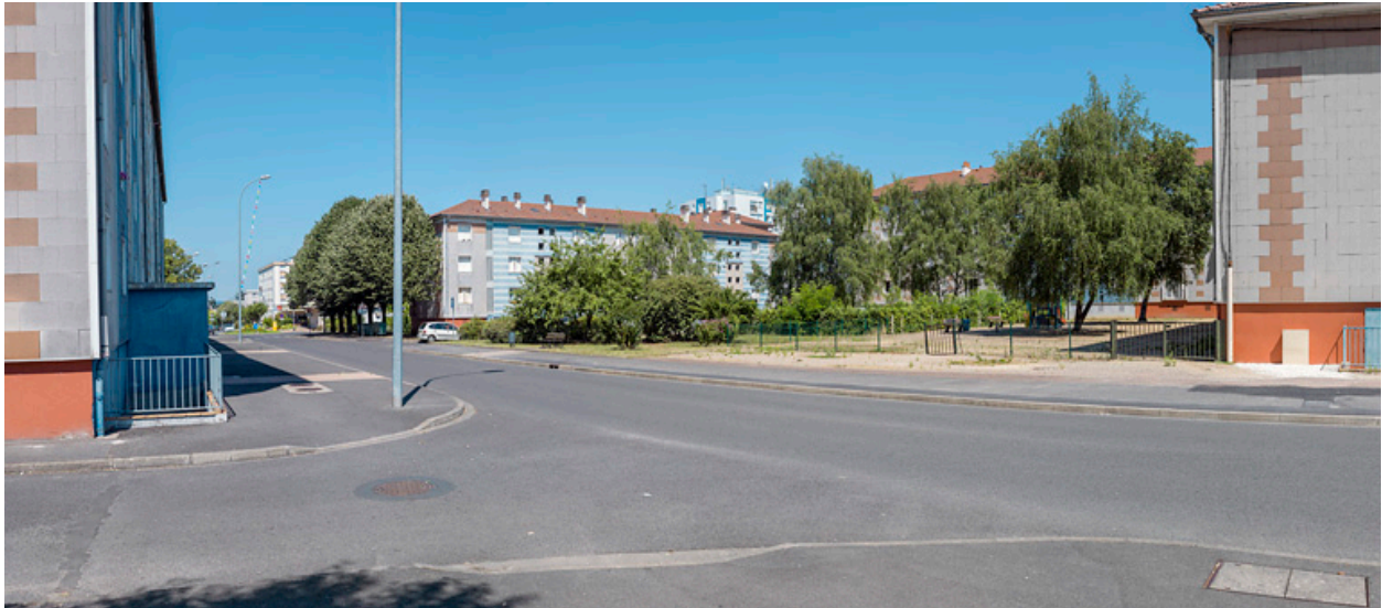
Vue depuis le croisement de l'avenue de la Paix et l'allée Antoine de Saint-Exupéry sur le square entre les bâtiments J, D et C.
