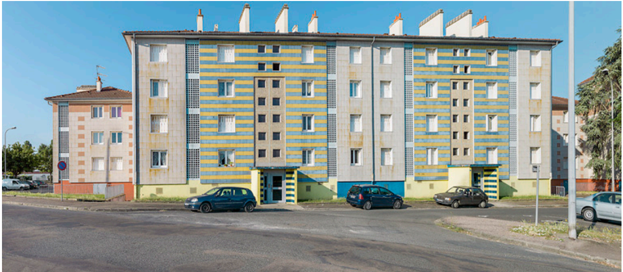
Bâtiment A, façade antérieure est.
