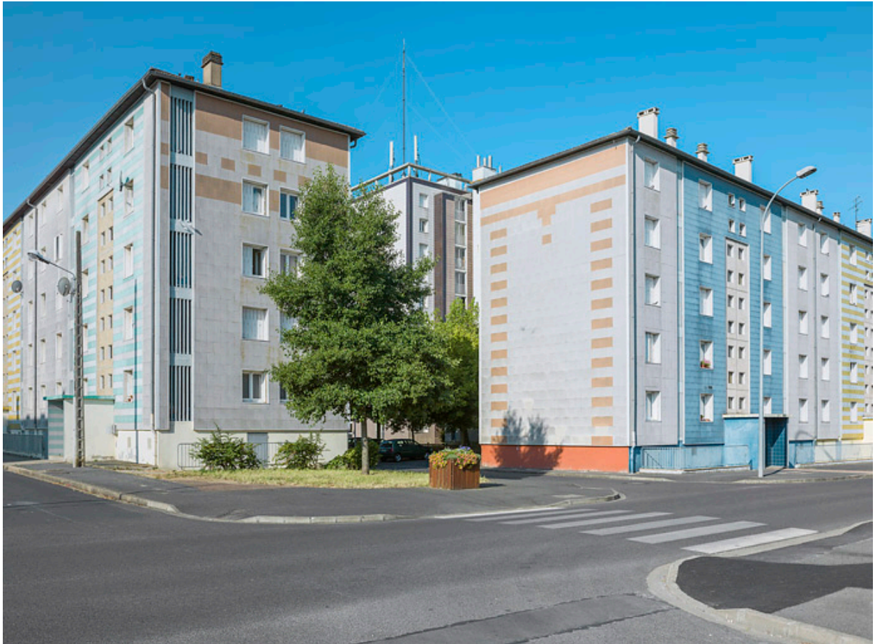
Bâtiments E et I, façades antérieures et latérales.
