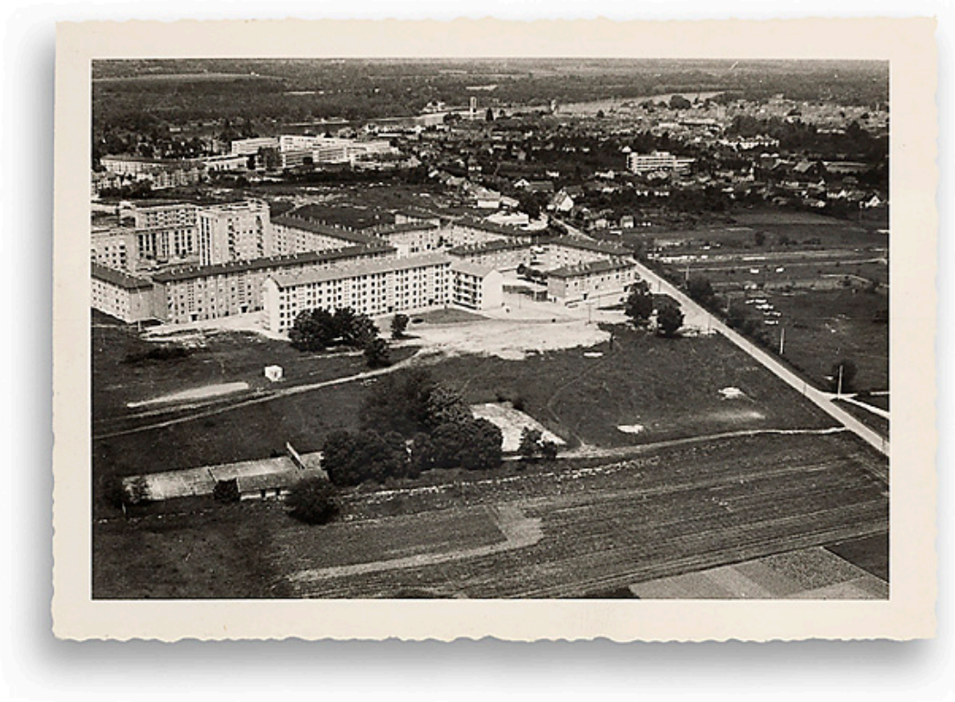
Vue aérienne du quartier Saint-Laurent en construction. Photographie ancienne, s.d., [1970-1971]. (Archives municipales Cosne-Cours-sur-Loire, 202W683 - 2Fi78)
