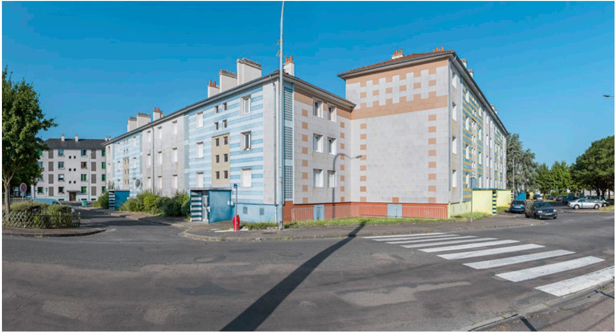
Bâtiments A et B, façades antérieures et latérales.
