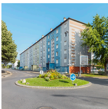
Bâtiment I, façade antérieure. Phot. Thierry Kuntz IVR26_20155800045NUC4A
