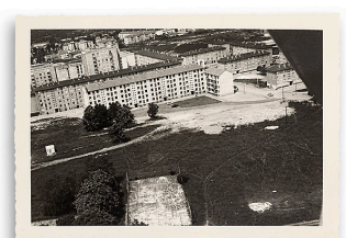
Vue aérienne du quartier Saint-Laurent en construction. Photographie ancienne, s.d., [1970-1971].
