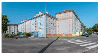
Bâtiments A et B, façades antérieures et latérales. Phot. Thierry Kuntz IVR26_20155800049NUC4A
