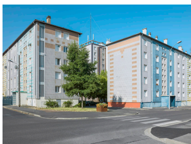
Bâtiments E et I, façades antérieures et latérales. Phot. Thierry Kuntz IVR26_20155800043NUC4A
