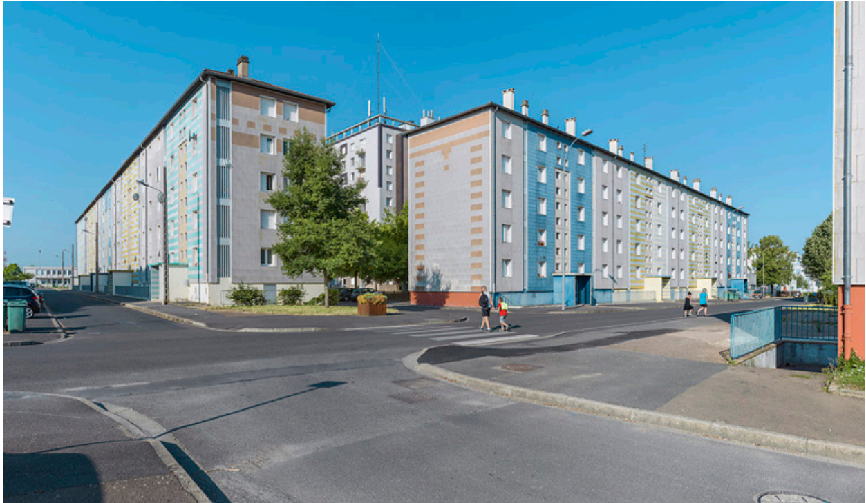
Bâtiments E et I, façades antérieures et latérales.
