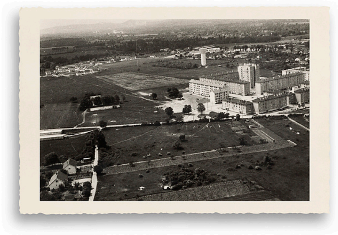
Vue aérienne du quartier Saint-Laurent en construction. Photographie ancienne, s.d., [1970-1971]. (Archives municipales Cosne-Cours-sur-Loire, 202W683 - 2Fi75)
