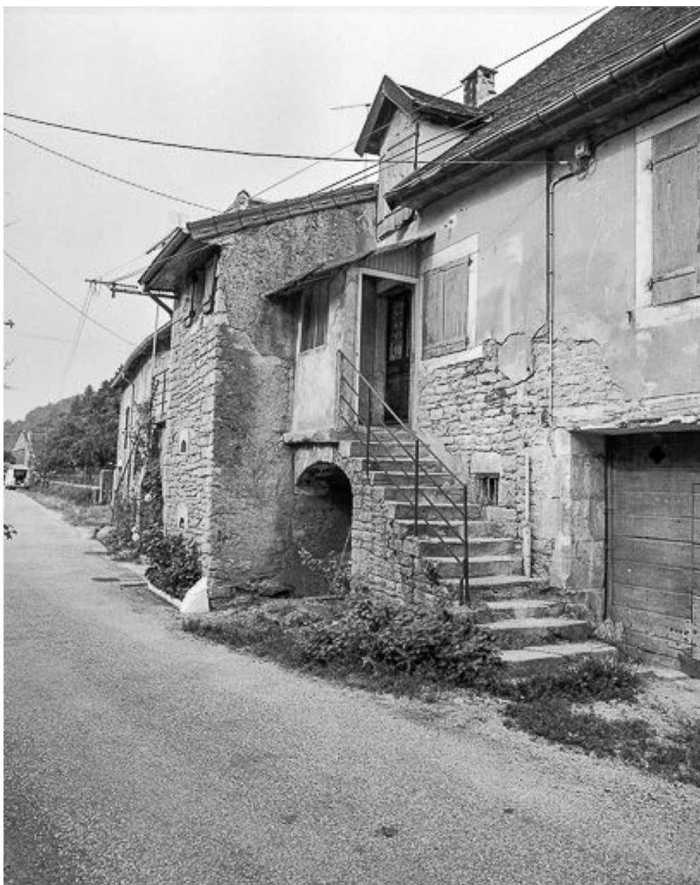
Façade antérieure : escalier à droite de l'avancée.
