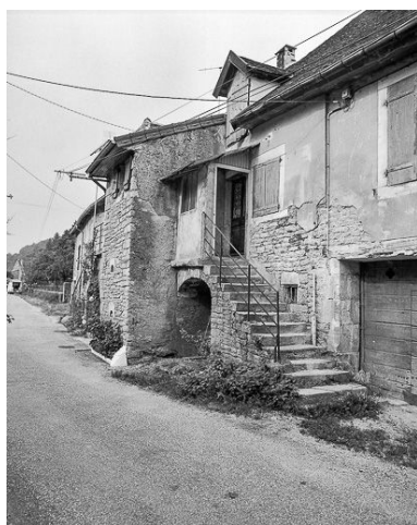
Façade antérieur : escalier à droite de l'avancée. Phot. Yves Sancey IVR43_19843900256X
