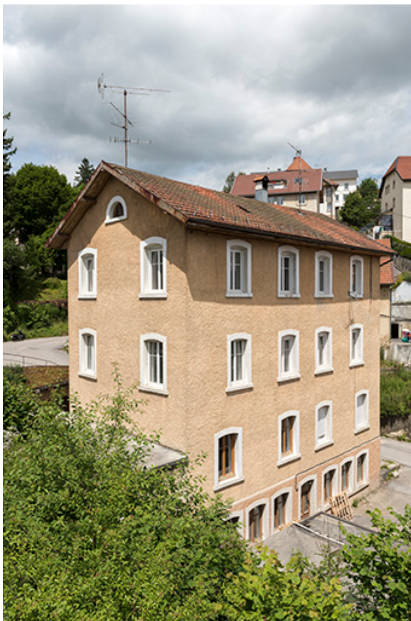
Façades postérieure et latérale droite.
