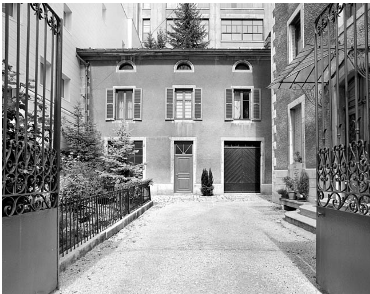
Façade antérieure de l'atelier.
