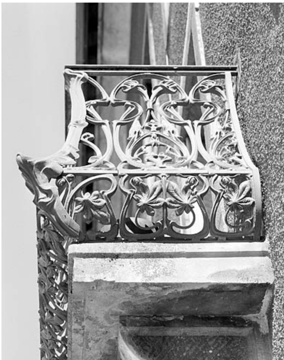
Balcon de l'immeuble : détail du garde-corps.
