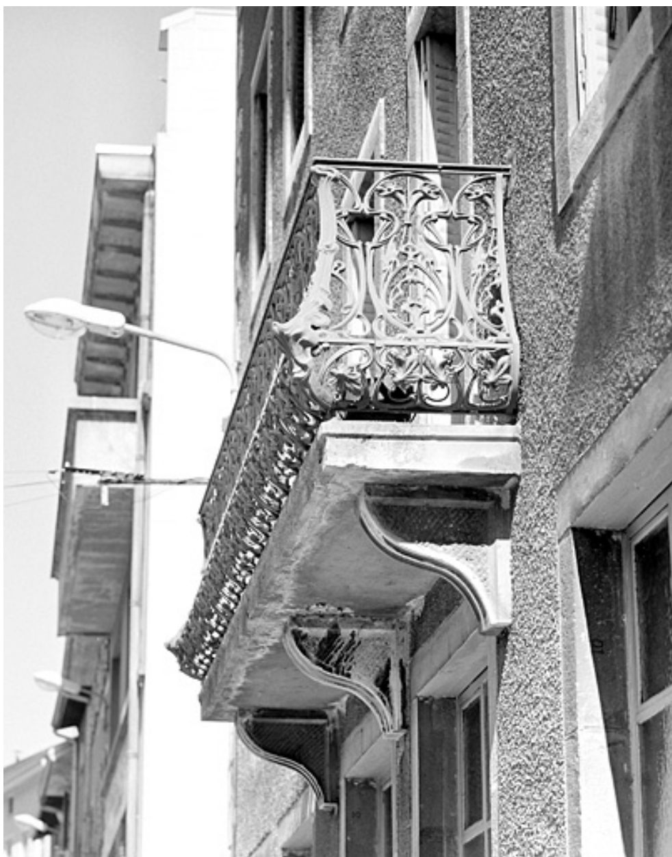
Balcon de l'immeuble, de profil.
