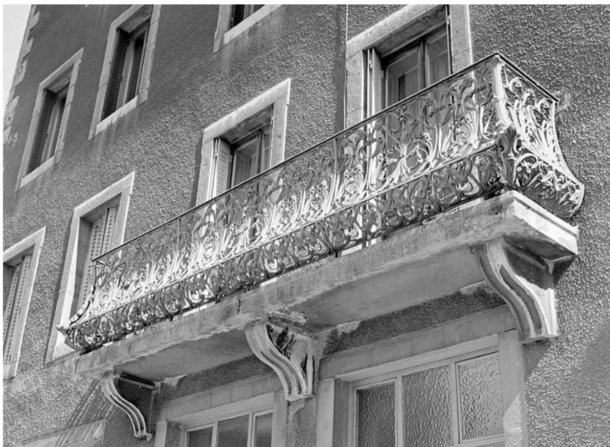
Balcon de l'immeuble.
