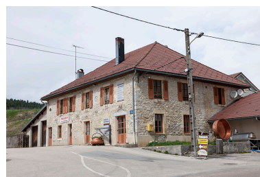
Vue de trois quarts droite. Phot. Jérôme Mongreville IVR43_20162500302NUC4A
