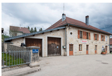
Vue de trois quarts gauche. Phot. Jérôme Mongreville IVR43_20162500301NUC4A
