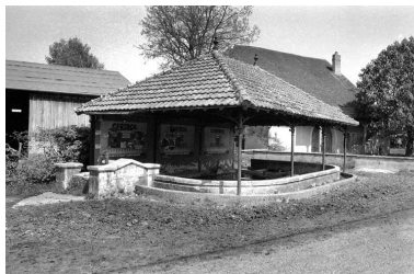
Vue d'ensemble, trois quarts gauche. Phot. Bernard Lardière IVR43_19817000349Z
