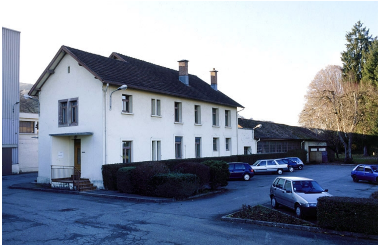
Bureau et atelier de réparation.
