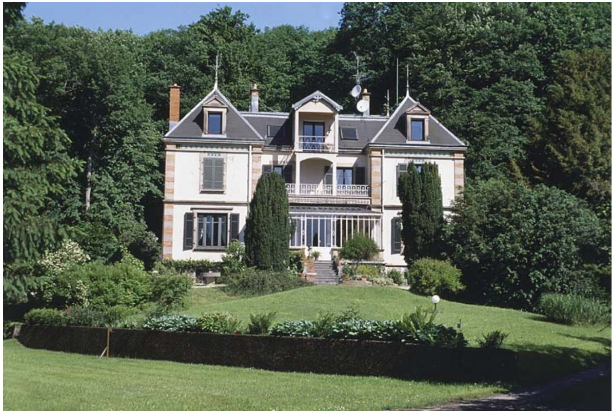
Façade antérieure du logement patronal.
