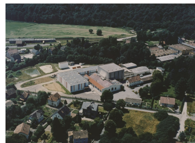
Vue aérienne depuis le sud-est. Phot. Jérôme Mongreville IVR43_20019000450XA
