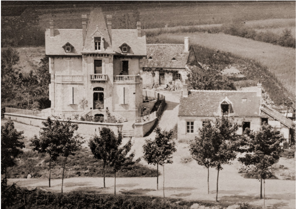
Corps de bâtiment secondaire de la future villa (à droite) près de la Villa Comoy (à gauche).
