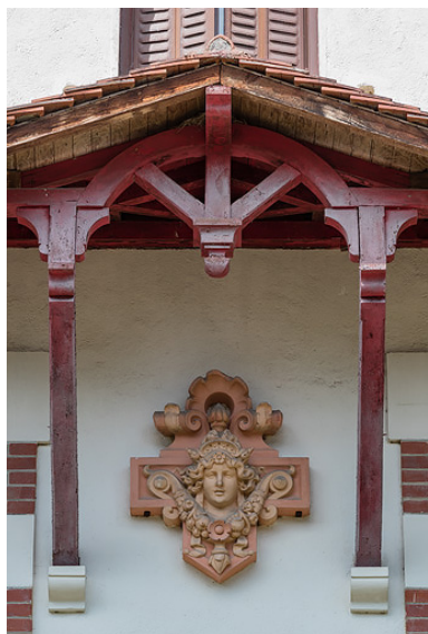
Auvent sur aisseliers abritant un masque féminin en terre cuite. Phot. Pierre-Marie Barbe-Richaud IVR26_20195800679NUC4A
