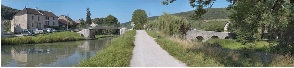
Pont sur canal et pont sur l'Ouche vus de l'aval.
