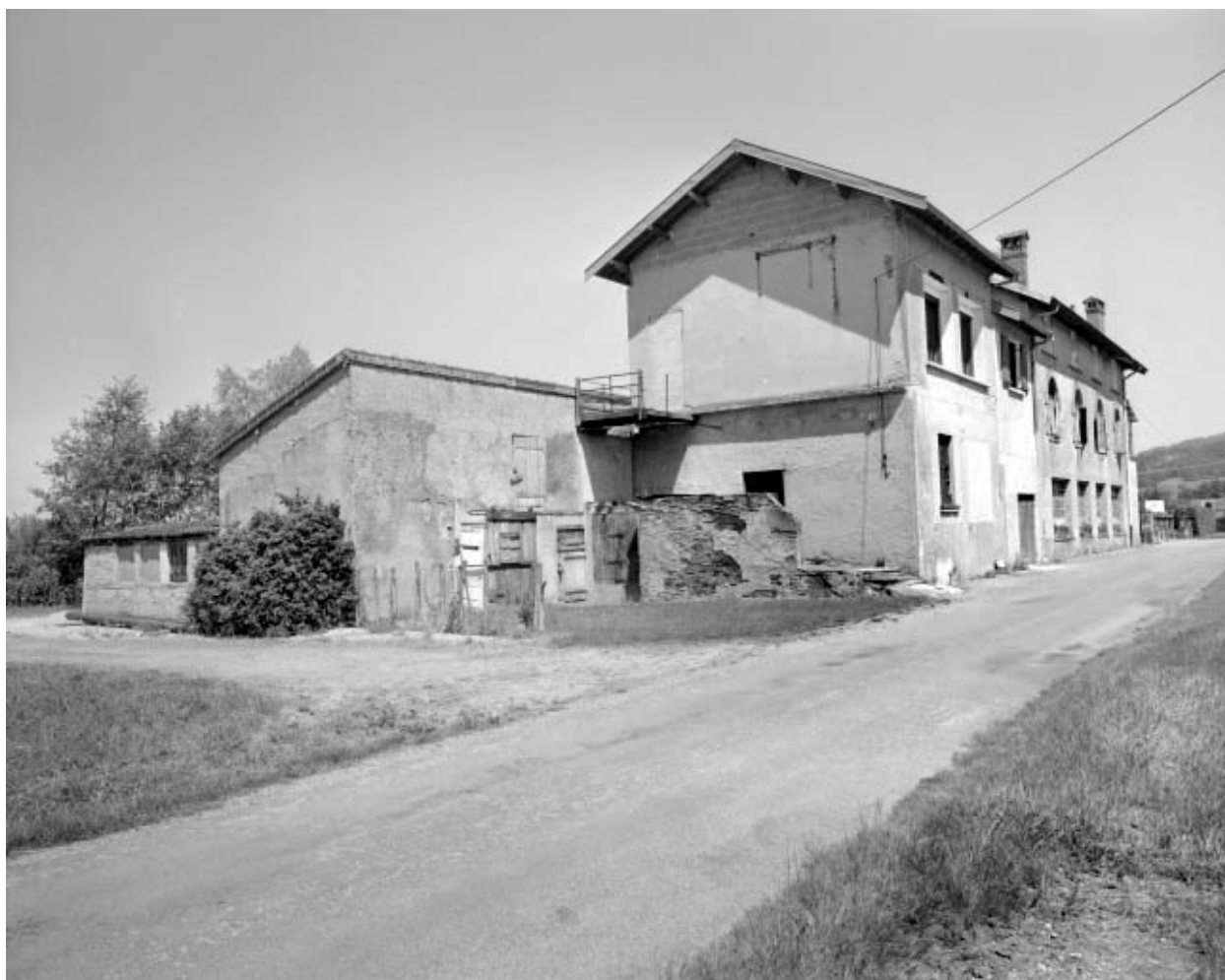
Logement et atelier de fabrication depuis l'ouest.
