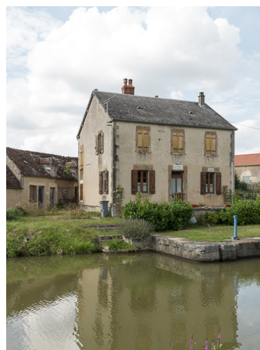
Vue de la maison éclusière. Phot. Pierre-Marie Barbe-Richaud IVR26_20175800334NUC2A
