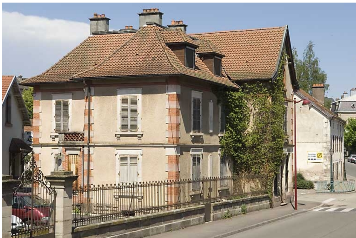
Logement patronal vu de trois quarts.
