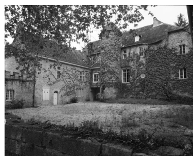
Façade sur cour et aile gauche. Phot. Yves Sancey IVR43_19813900081X
