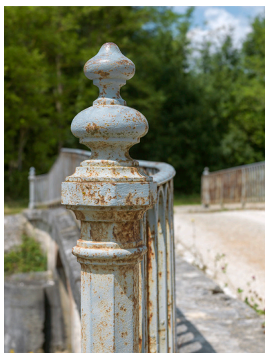
Détail du garde corps. Phot. Thierry Kuntz IVR26_20138900099NUC4A
