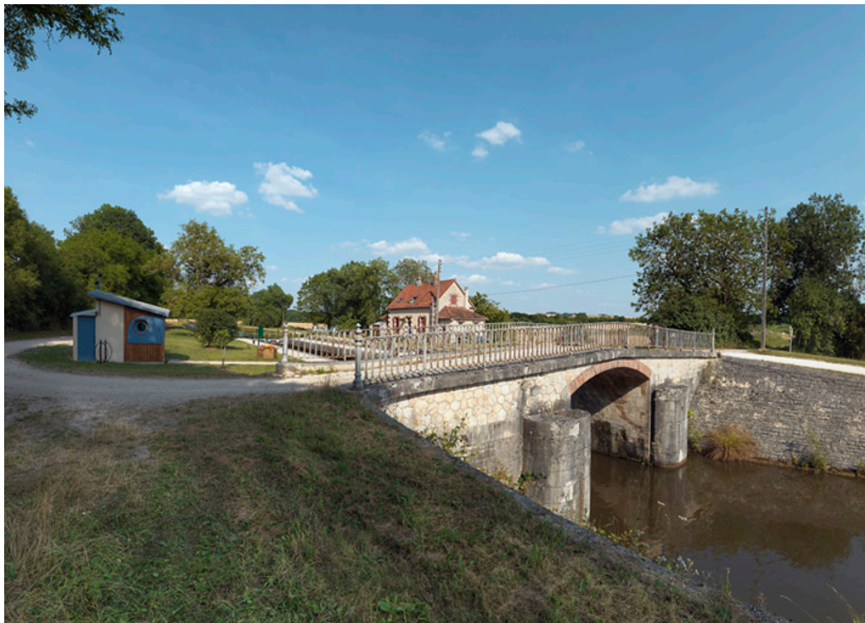
Le pont avec en arrière-plan le site d'écluse.
