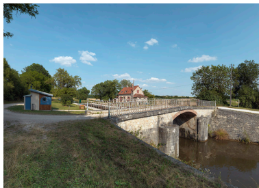
Le pont avec en arrière- plan le site d'écluse. Phot. Thierry Kuntz IVR26_20138900088NUC4A
