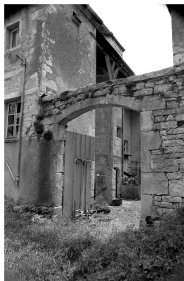
Cour sur façade postérieure. Phot. Bernard Lardière IVR43_19817000674Z
