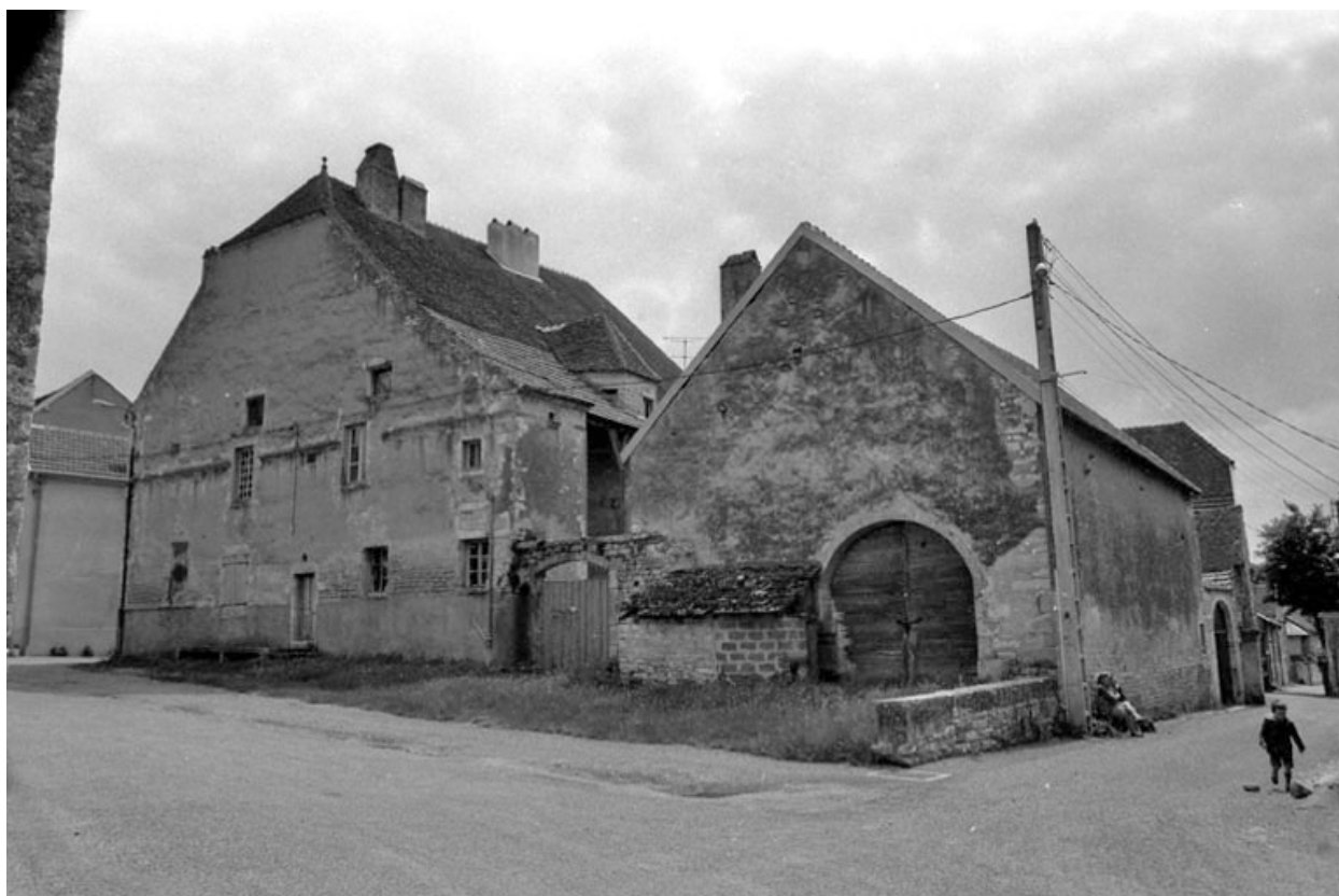
Façade latérale droite et bâtiment agricole.
