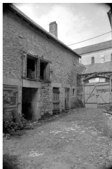
Bâtiments agricoles sur cour. Phot. Bernard Lardière IVR43_19817000679Z
