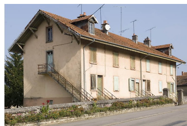
Logement d'ouvriers, bâtiment N, 24 grande rue. Phot. Jérôme Mongreville IVR43_20077000546NUCA
