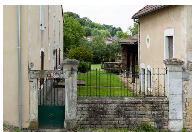
Maison, 6 impasse du sentier. Vue rapprochée. Phot. Sonia Dourlot IVR43_20157001273NUC2A
