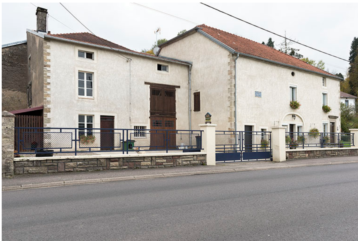
Maison 35, grande rue, vue de trois-quart nord-est.
