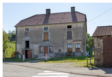
Maison 2 rue Saint isidore Phot. Sonia Dourlot IVR43_20157001377NUC2A
