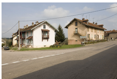
Logements ouvriers à l'angle de la grande rue et de la route de Passavant. Phot. Jérôme Mongreville IVR43_20077000548NUCA
