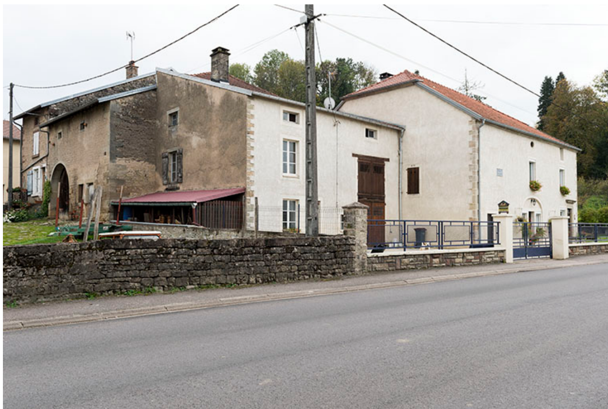
Maison 35, grande rue, vue de trois-quart est.
