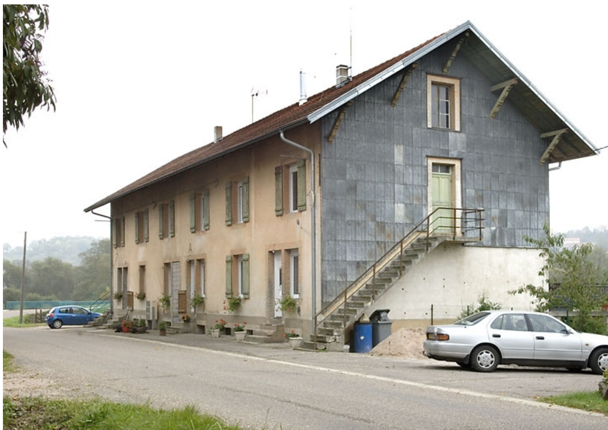
Logements d'ouvriers, bâtiment A, rue du Coney.
