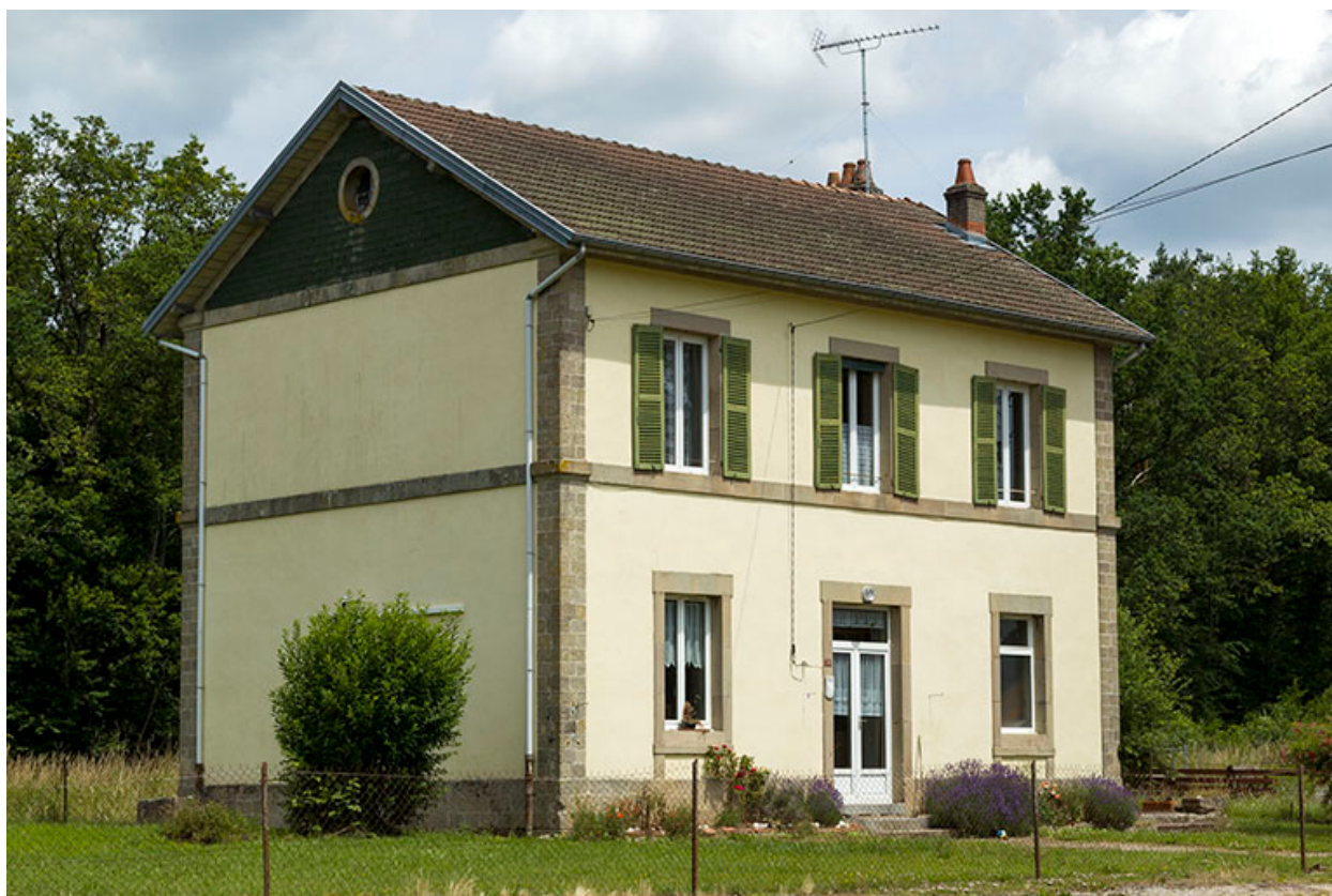
Ancienne gare, 30 rue de la filature.
