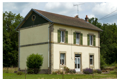
Ancienne gare, 30 rue de la filature. Phot. Sonia Dourlot IVR43_20157001297NUC2A
