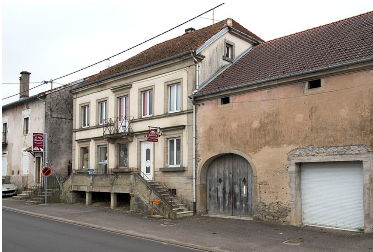
Détail de l'alignement grande rue : ancienne boulangerie.
