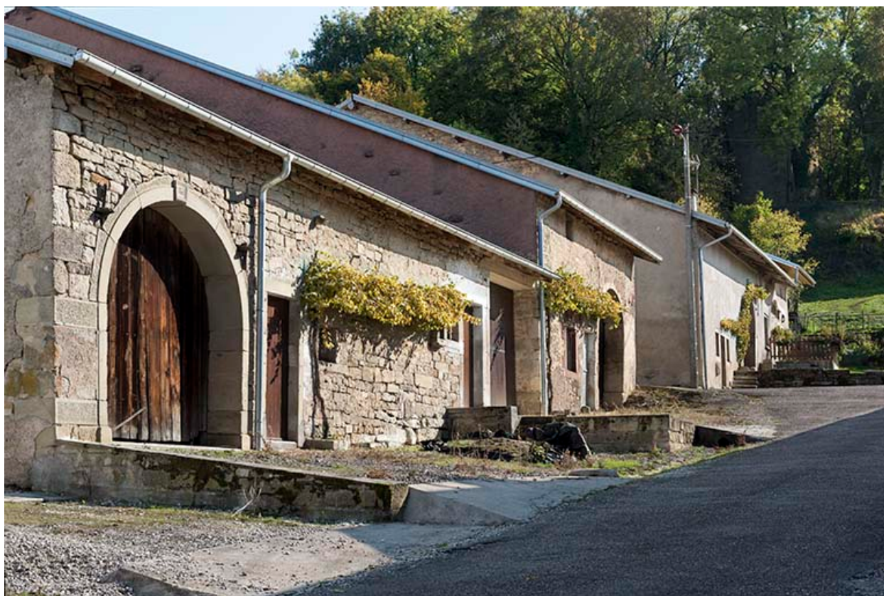
Alignement rue de la fontaine.
