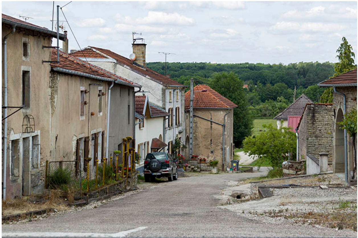
Alignement rue de la fontaine.
