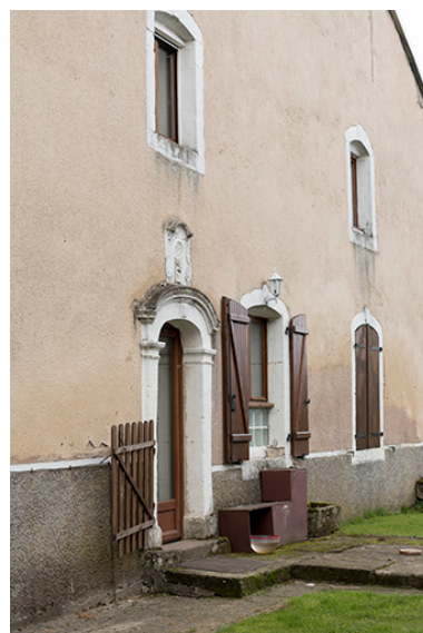
Détail de la façade antérieure. Phot. Sonia Dourlot IVR43_20157001275NUC4A
