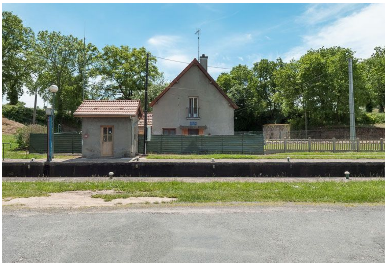
Vue de face de la maison éclusière.
