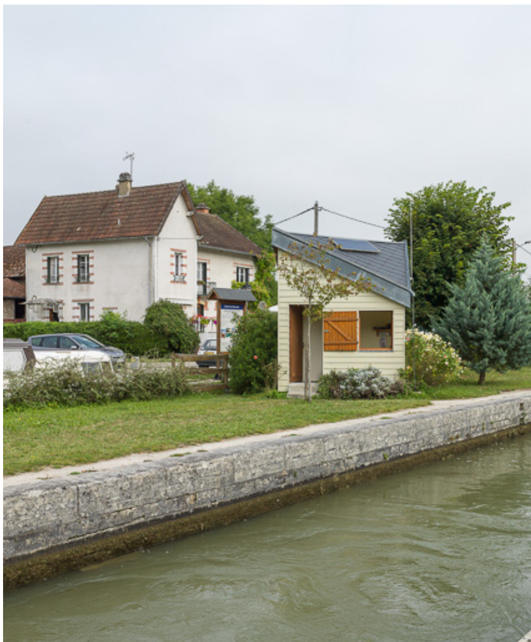
Maison du garde barrière.
