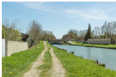
Le pont et le site d'écluse vus d'aval. Phot. Pierre-Marie Barbe-Richaud IVR26_20138900042NUC4AQ
