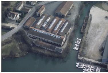
Vue aérienne de l'usine actuelle. Phot. J.-P. (photographe) NEPASUTILISERBévalot IVR43_19987000038ZA
