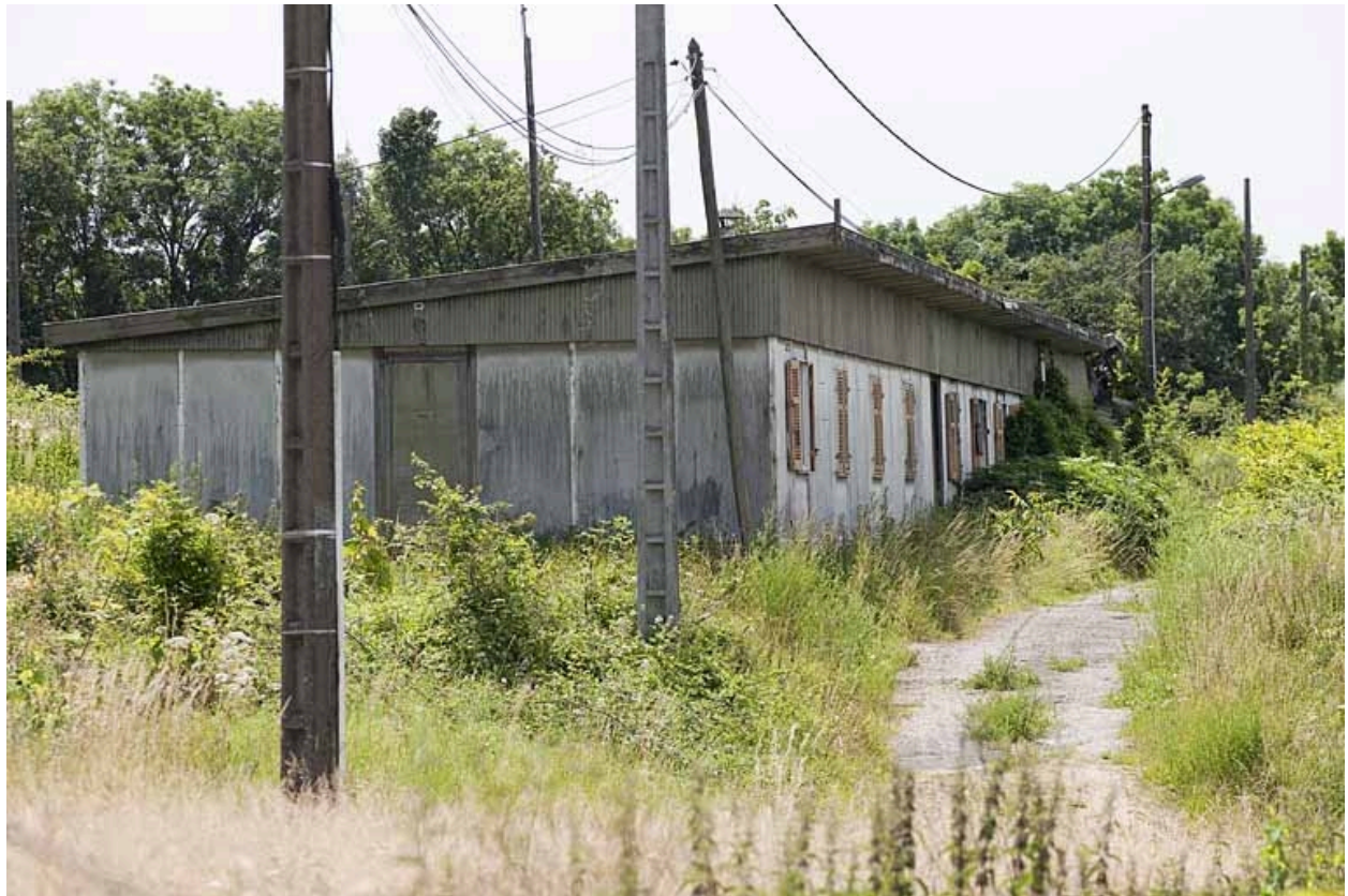
Logement P (en ruines).
