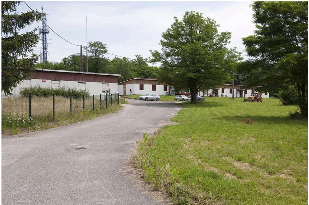
Logements N et L vus depuis l'ouest.
