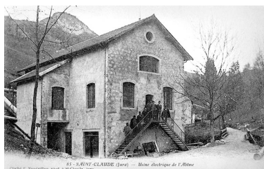
Saint-Claude (Jura) - Usine électrique de l'Abîme. Phot. Jérôme Mongreville, Phot. E. Mandrillon IVR43_19923900052X
