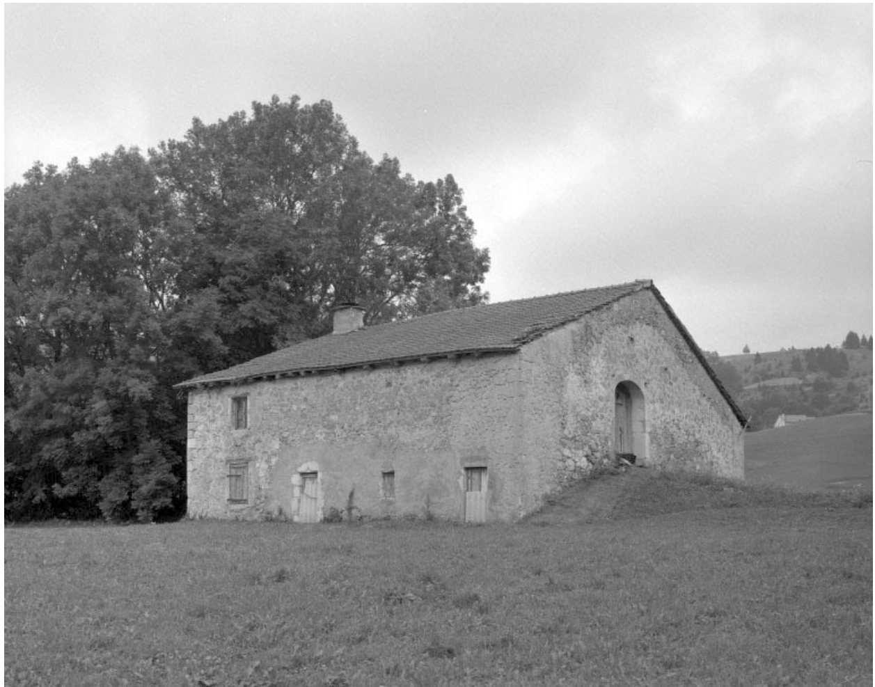
Façade postérieure et face droite.
