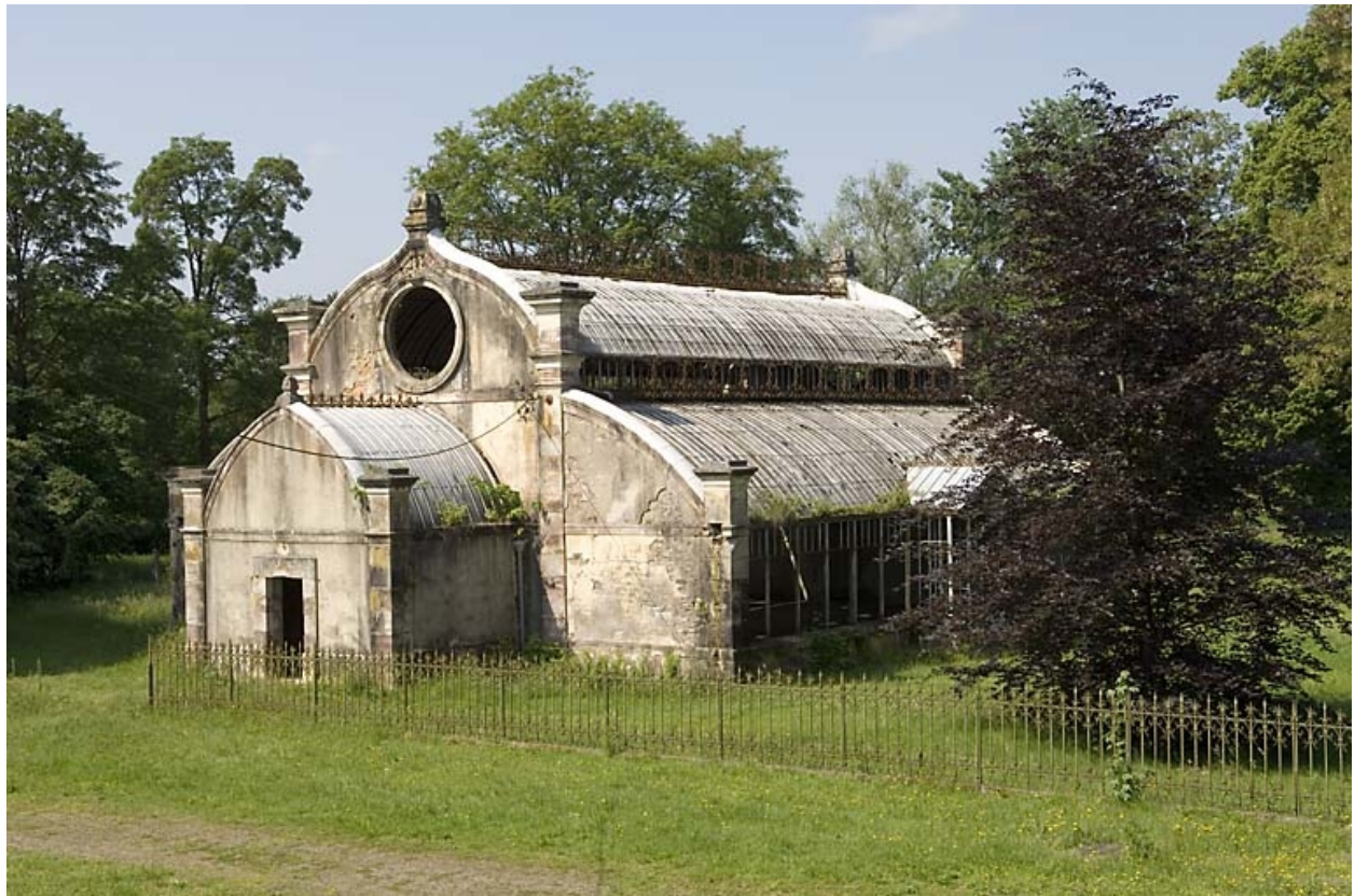
Vue d'ensemble de la serre.
