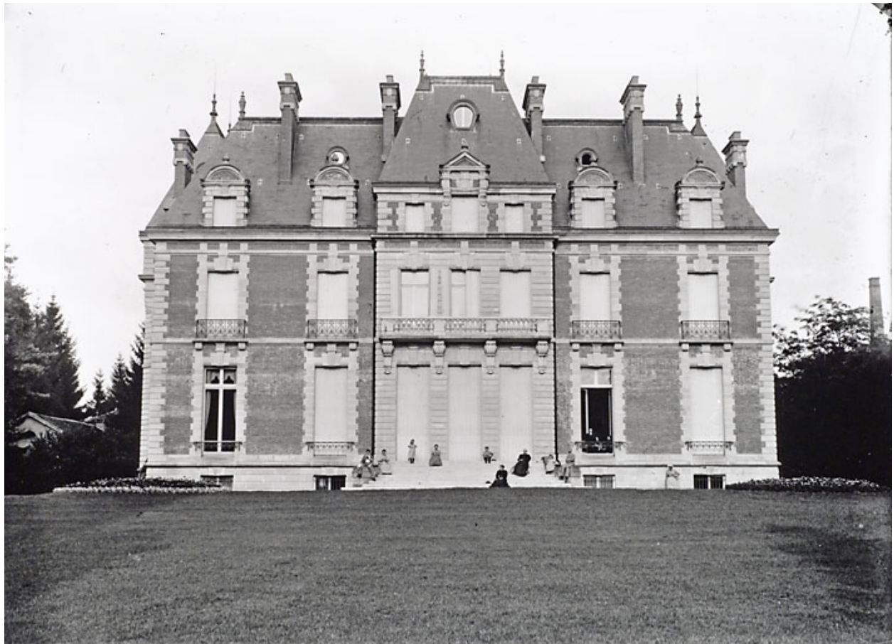
Façade occidentale de la nouvelle demeure patronale.
