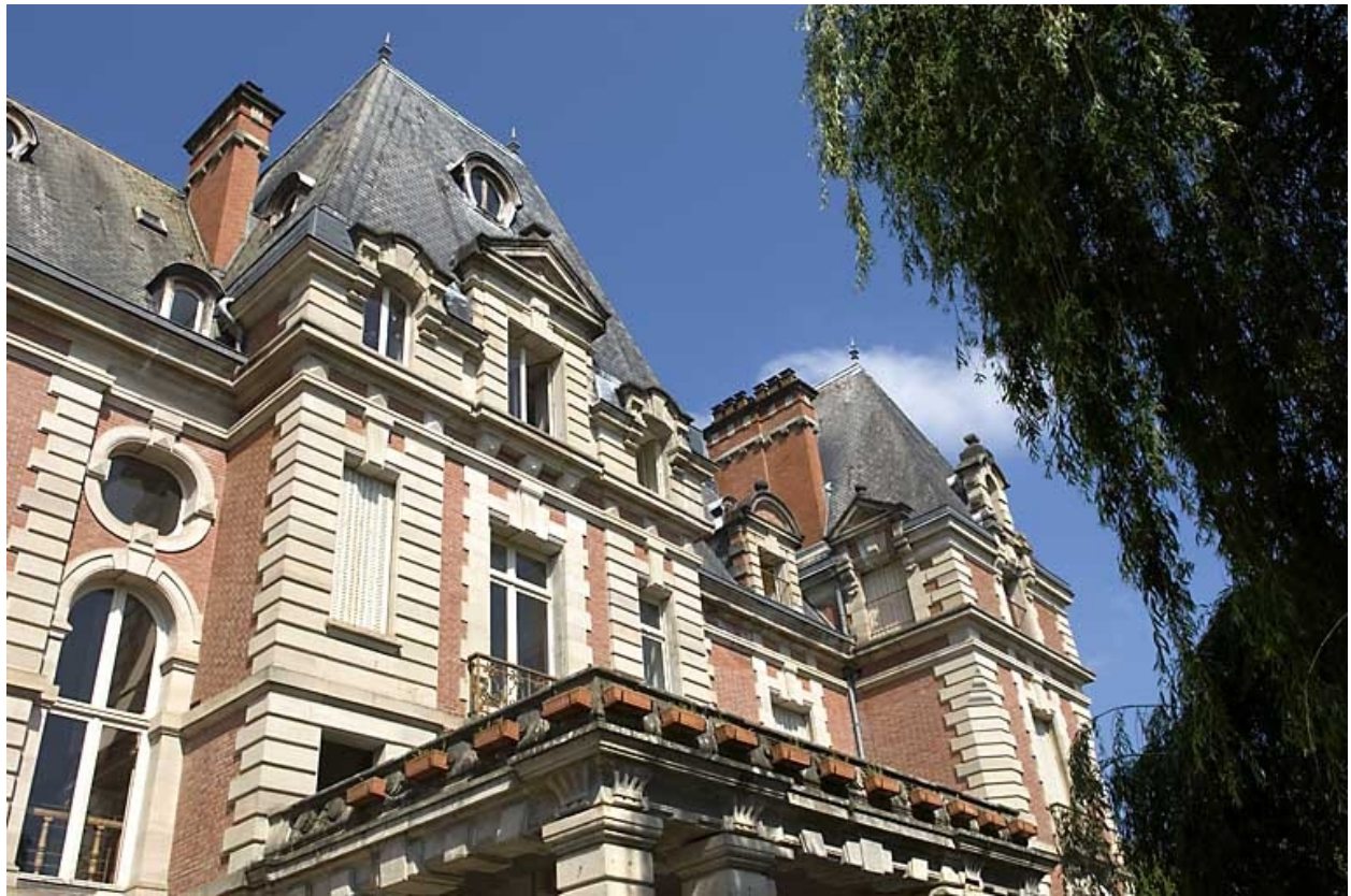
Logement patronal. Détail de la façade antérieure.
