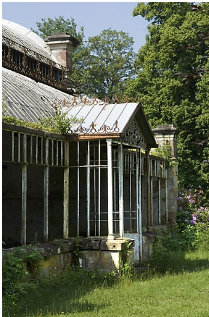
Serre. Détail de la façade nord.
