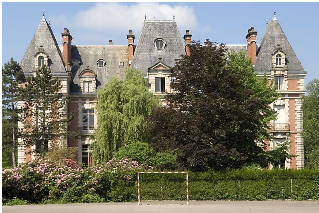
Logement patronal. Façade antérieure.
