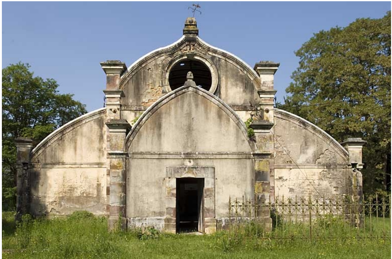
Serre. Mur-pignon est.
