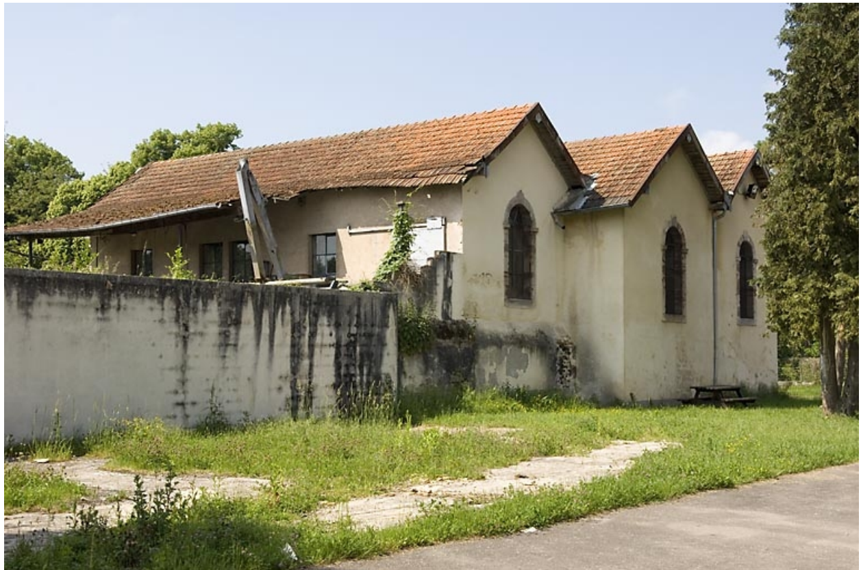
Centrale hydroélectrique. Vue de trois quarts arrière.
