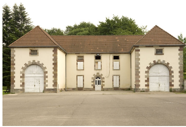
Ecuries et remises. Vue de face. Phot. Jérôme Mongreville IVR43_20077000344NUCA
