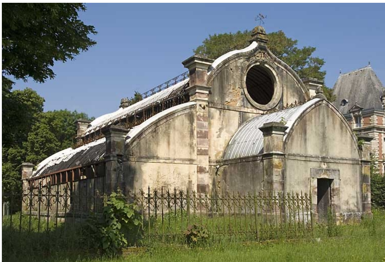
Serre. Vue depuis le sud-est.
