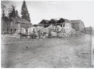
Démolition de l'ancienne filature (magasins de stockage ?). Phot. Jérôme Mongreville IVR43_20077000379NUCA
