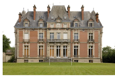
Logement patronal. Façade postérieure. Phot. Jérôme Mongreville IVR43_20077000354NUCA
