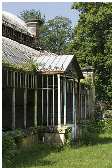
Serre. Détail de la façade nord. Phot. Jérôme Mongreville IVR43_20077000302NUCA
