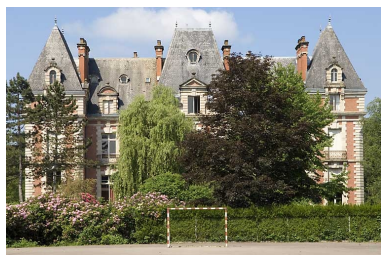
Logement patronal. Façade antérieure. Phot. Jérôme Mongreville IVR43_20077000358NUCA
