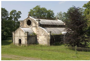
Vue d'ensemble de la serre. Phot. Jérôme Mongreville IVR43_20077000299NUCA
