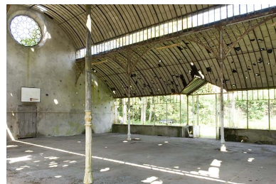
Intérieur de la serre. Vue de côté. Phot. Jérôme Mongreville IVR43_20077000304NUCA
