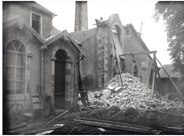
Démolition de l'ancienne filature (salle des machines ?). Phot. Jérôme Mongreville IVR43_20077000380NUCA
