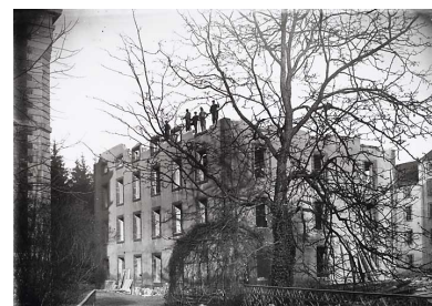
Démolition de l'ancienne filature. Phot. Jérôme Mongreville IVR43_20077000371NUCAB
