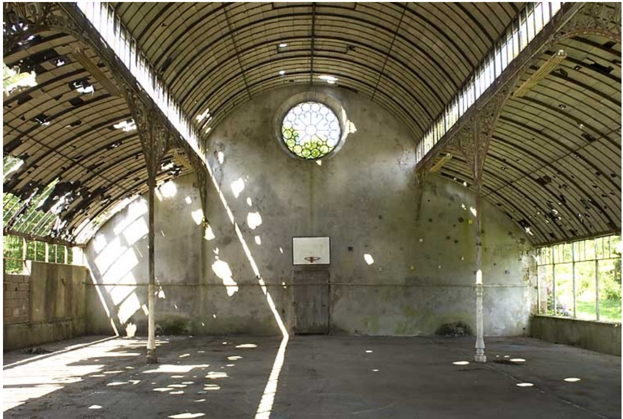
Intérieur de la serre. Vue depuis l'est.
