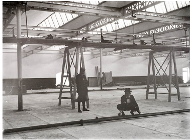
Installation du système de chauffage dans la nouvelle filature. Phot. Jérôme Mongreville IVR43_20077000374NUCAB
