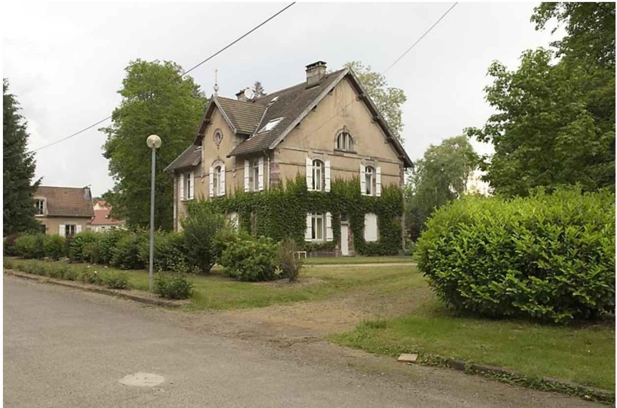
Logement (ancien chenil). Vue depuis le sud.
