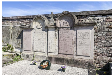
Vue d'ensemble. Phot. Fabien Dufoulon IVR43_20217000429NUC2A
