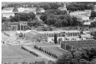
Le site de la halle des grues et des locos vu depuis lenord (à droite, la SNECMA). Phot. Frédéric Pillet IVR26_20007100401Z
