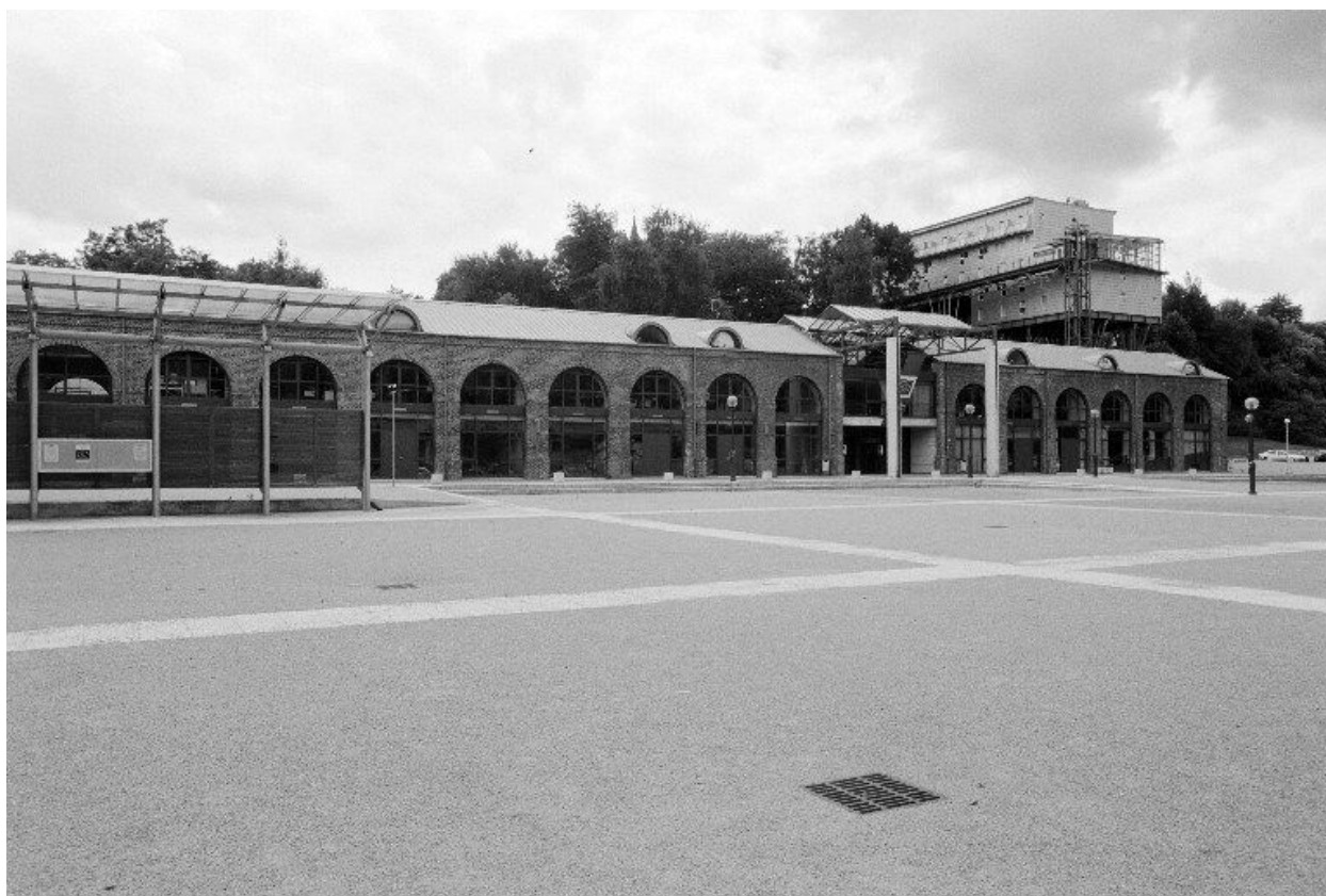
Façade nord de l'ancien atelier d'ajustage (tournerie).
