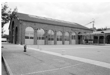
La halle des grues et des locos vue du nord-ouest. Phot. Frédéric Pillet IVR26_20007100402Z
