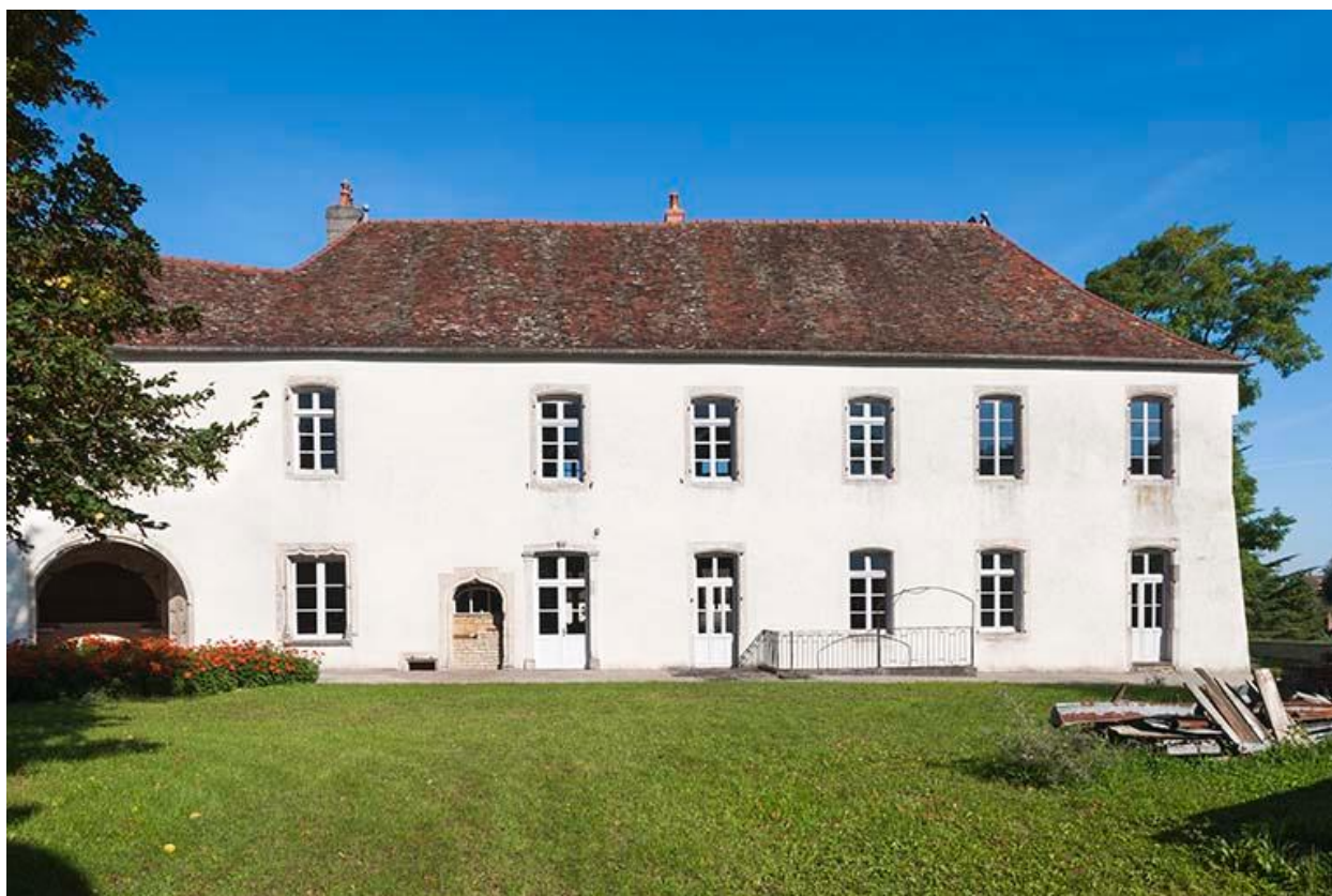
Vue générale sud
