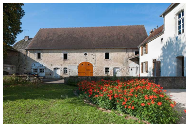
Les écuries et granges Phot. Jérôme Mongreville IVR43_20137000320NUCA
