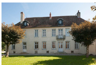
Façade nord Phot. Jérôme Mongreville IVR43_20137000330NUCA
