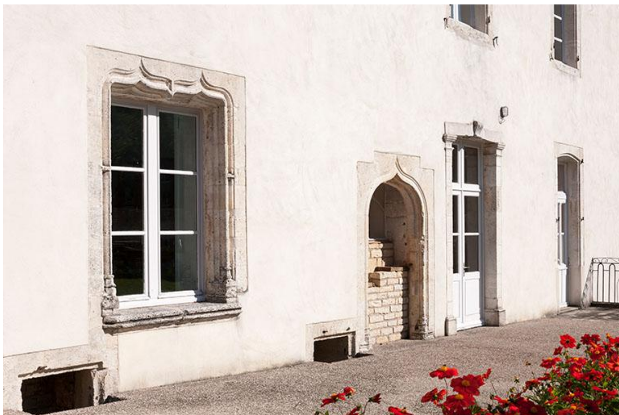
Détail de la façade sud
