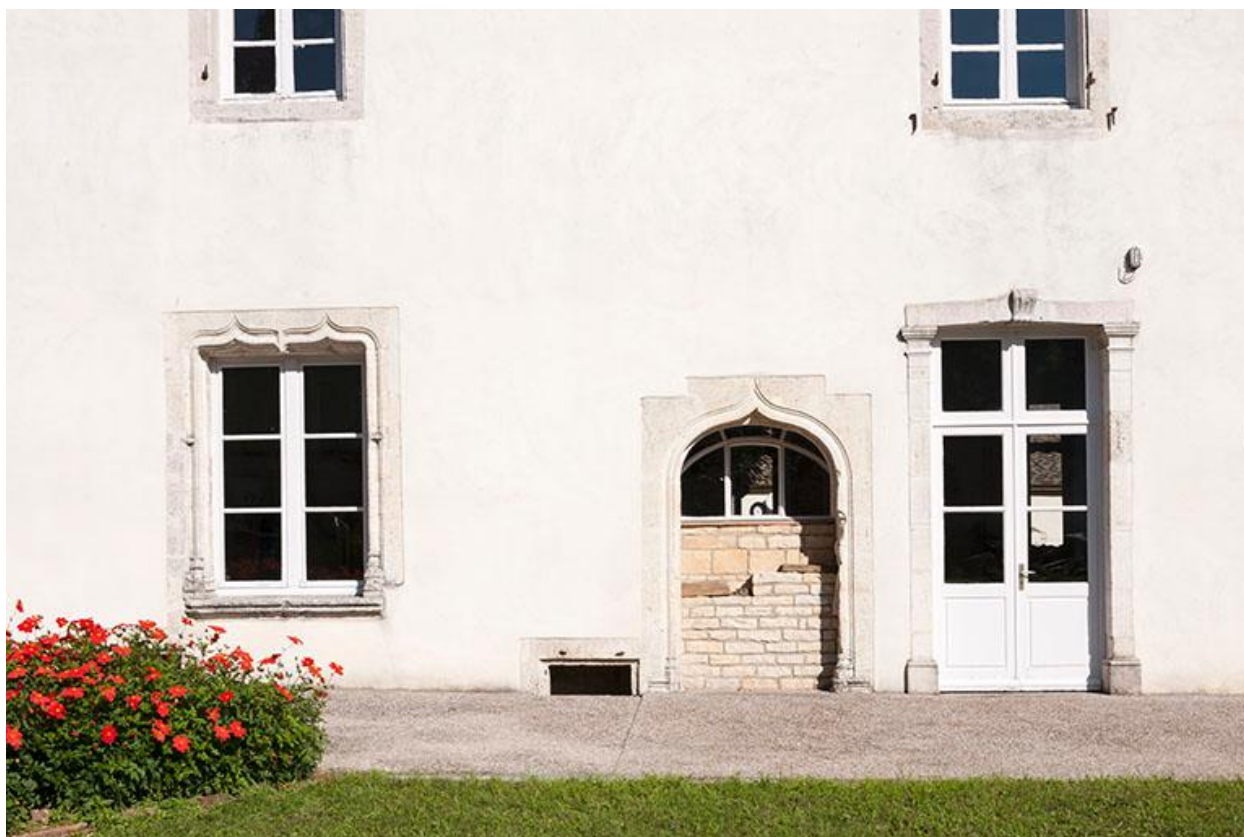
Détail de la façade sud
