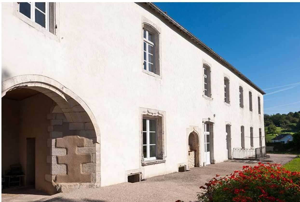
Vue sud-ouest du logis
