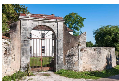
Vue sud Phot. Jérôme Mongreville IVR43_20137000161NUCA
