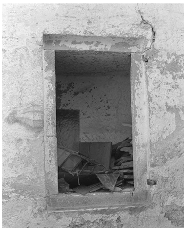
Petit placard à feuillure. Phot. Michel Thierry IVR26_19748900897X
