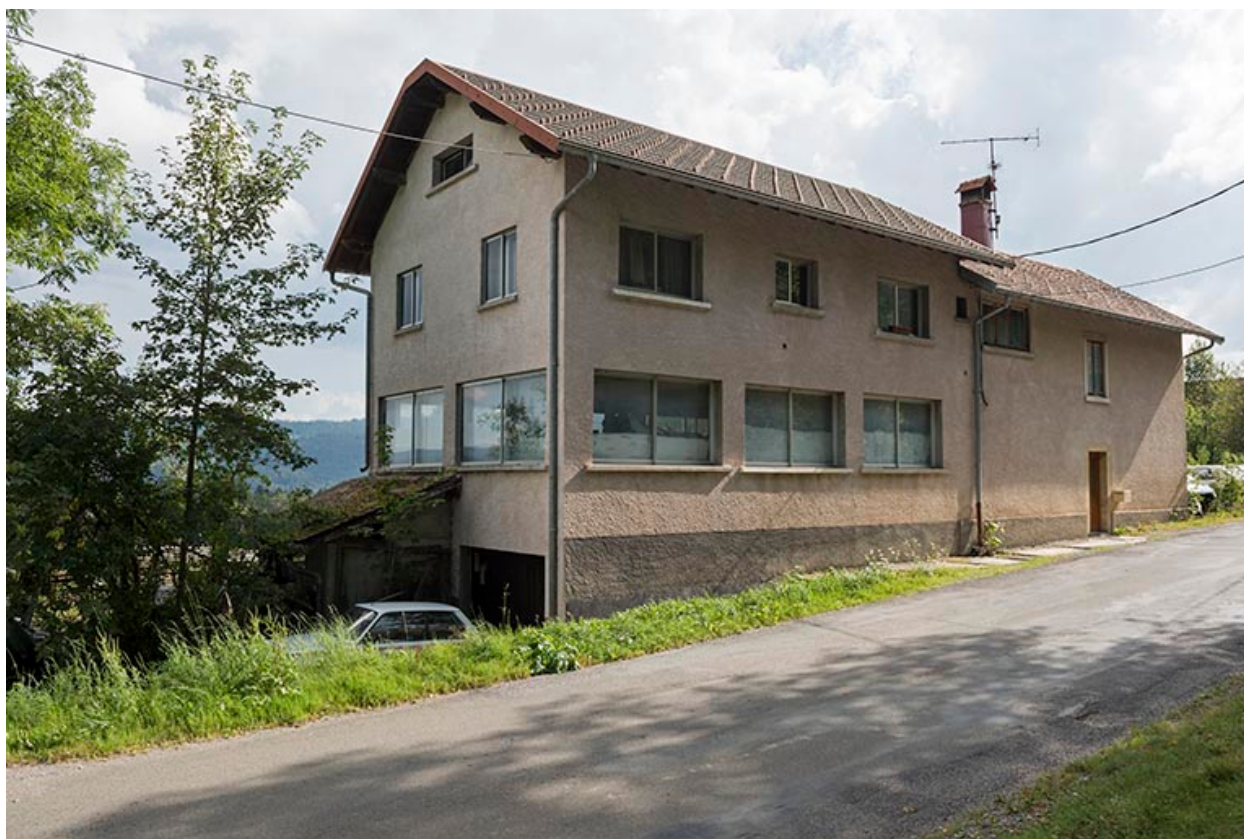
Façades antérieure et latérale gauche.
