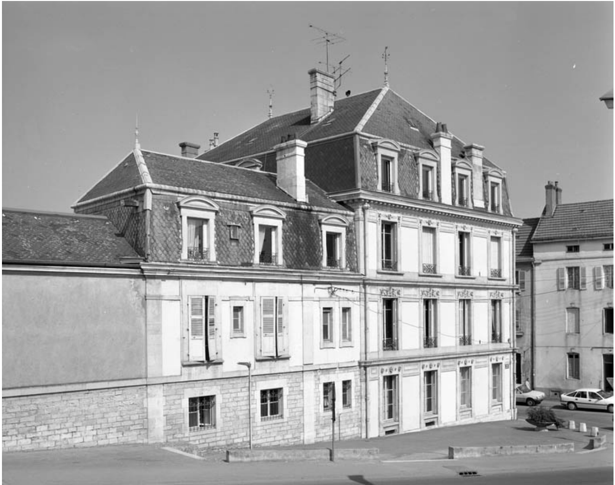
façade latérale, de trois quarts gauche.
