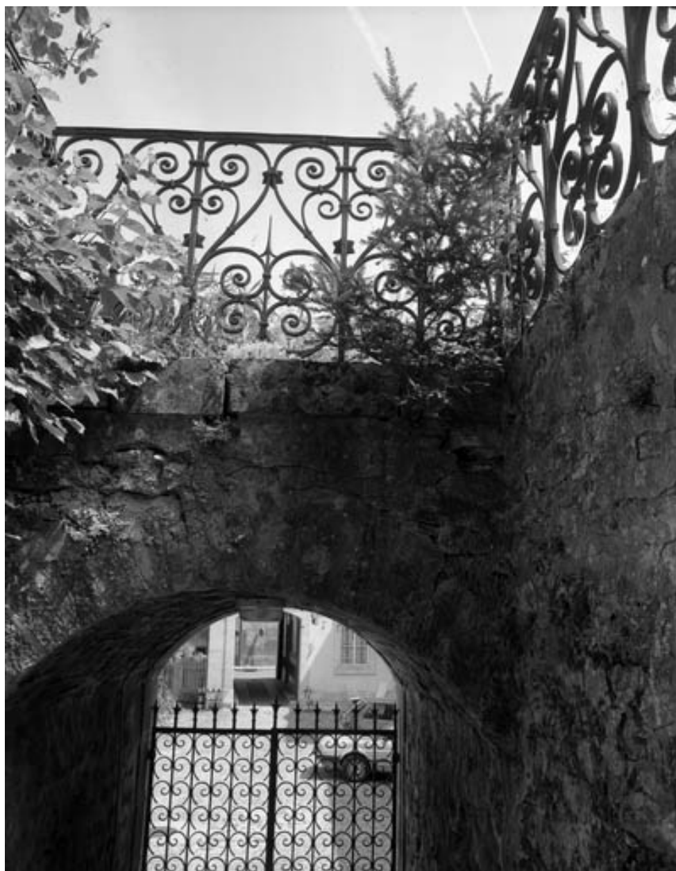
Détail du parapet de l'escalier du jardin.
