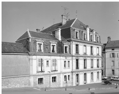
façade latérale, de trois quarts gauche. Phot. Yves Sancey IVR43_19917000242X
