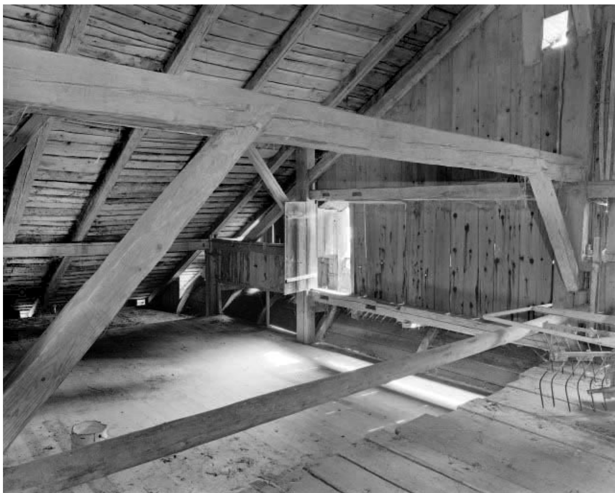
Charpente et lambreques antérieure à surplomb cintré.
