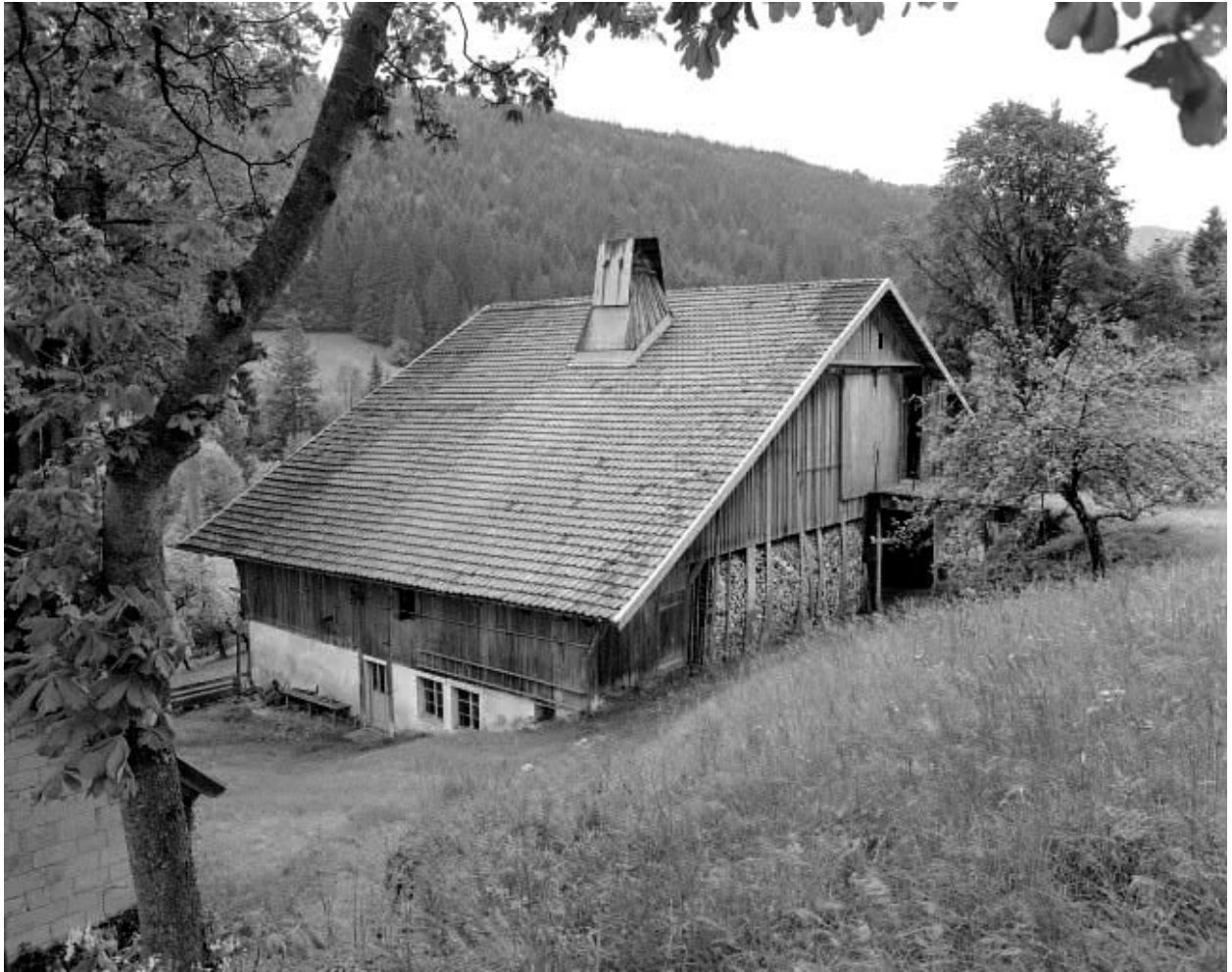
Extérieur : façades postérieure et latérale droite.
