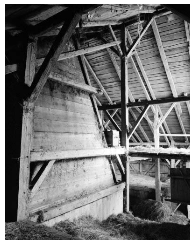
Charpente et tué. Phot. Yves Sancey IVR43_19772500320X
