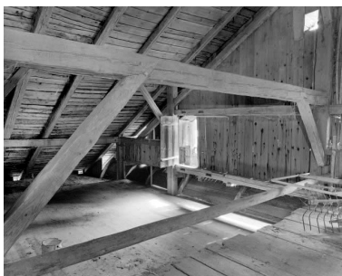
Charpente et lambrequine antérieure à surplomb cintré. Phot. Yves Sancey IVR43_19772500319X
