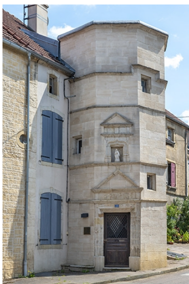
Vue rapprochée de la tour d'escalier, face à sa porte. Phot. Jérôme Mongreville IVR43_20217000239NUC4A
