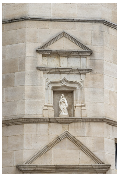
Vue rapprochée des deux frontons et de la sculpture de la tour d'escalier. Phot. Jérôme Mongreville IVR43_20217000241NUC4A
