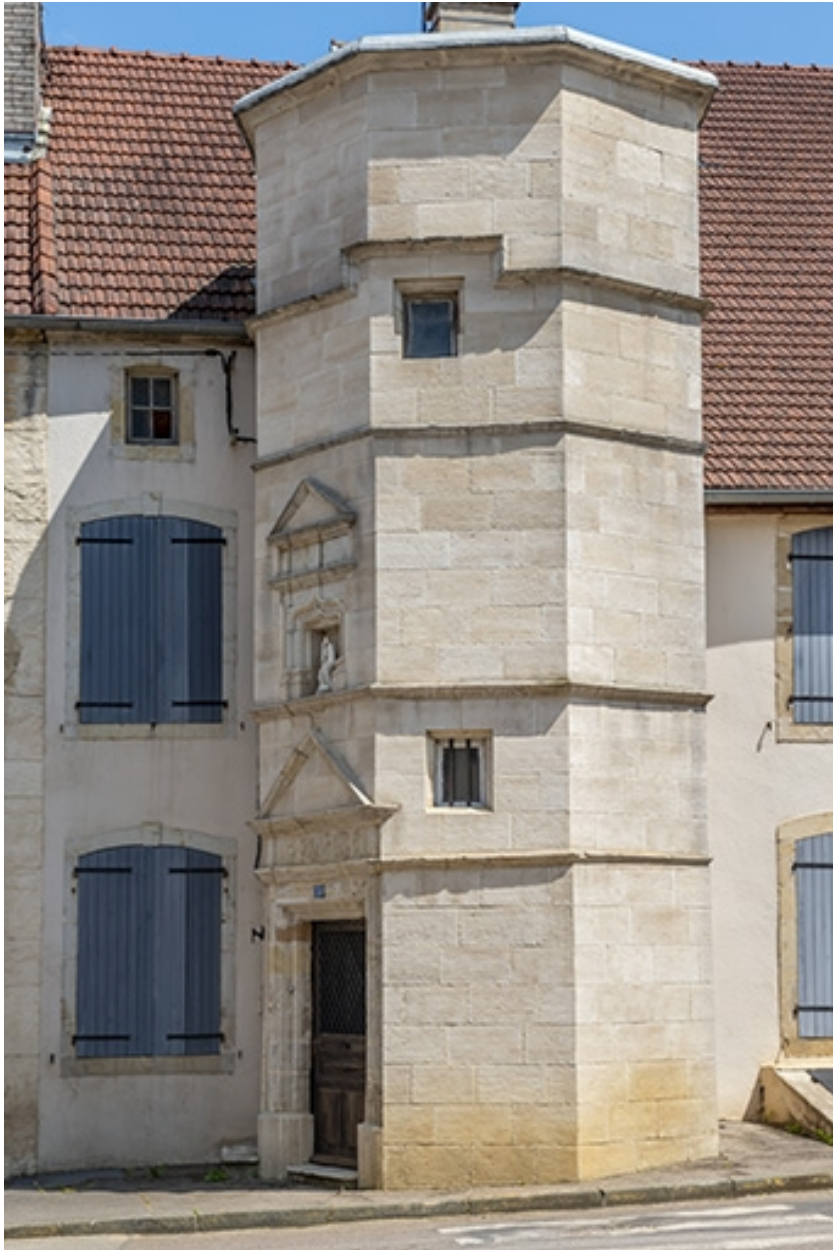
Vue rapprochée de la tour d'escalier.
