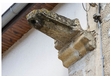
La gargouille à l'extrémité sud de la façade. Phot. Jérôme Mongreville IVR43_20217000246NUC4A
