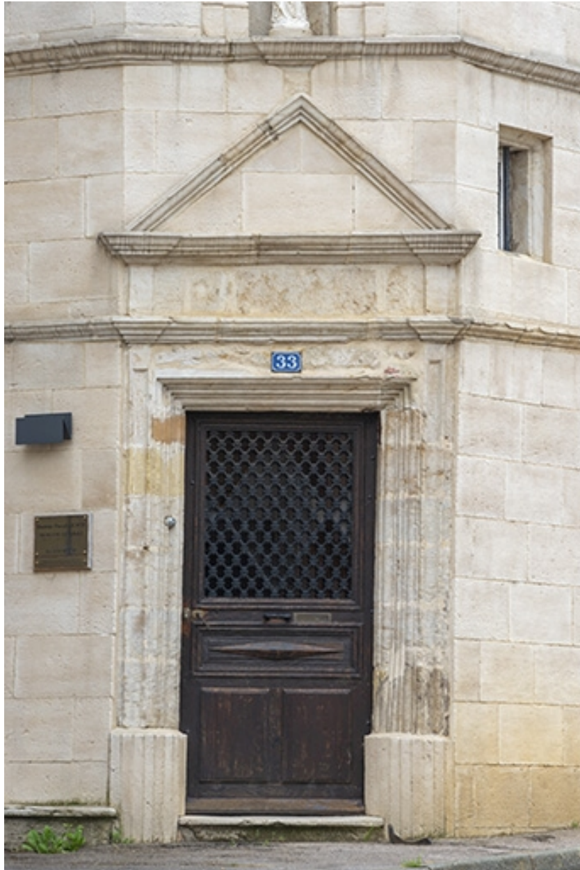
Vue rapprochée de la porte d'entrée.
