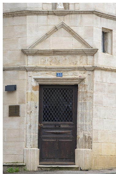
Vue rapprochée de la porte d'entrée. Phot. Jérôme Mongreville IVR43_20217000240NUC4A
