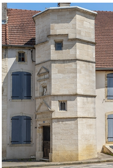
Vue rapprochée de la tour d'escalier. Phot. Jérôme Mongreville IVR43_20217000237NUC4A
