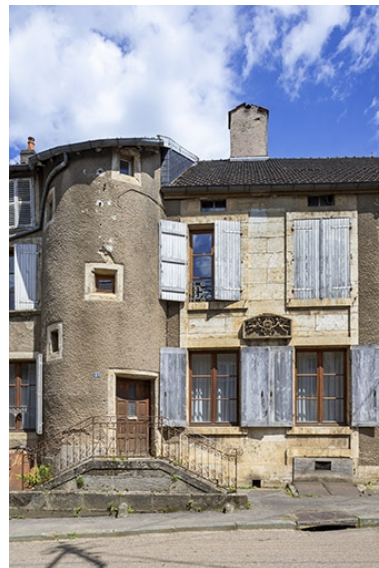
La façade antérieure, vue rapprochée. Phot. Jérôme Mongreville IVR43_20217000221NUC4A
