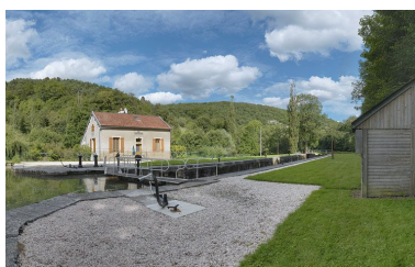
Vue d'amont du site d'écluse 17. Phot. Thierry Kuntz IVR26_20122102242NUC4A
