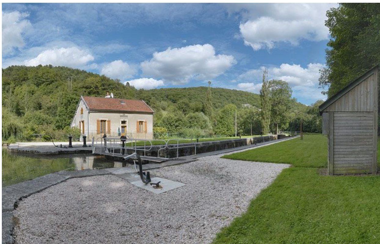
Vue d'amont du site d'écluse 17.
