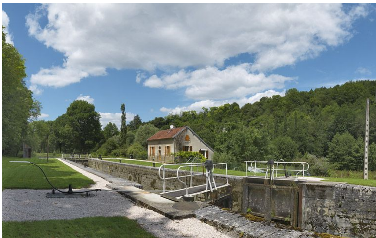
Vue d'aval du site d'écluse 17.
