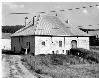
Façade postérieure avec accès aux parties agricoles. Phot. Jérôme Mongreville IVR43_19943900783X
