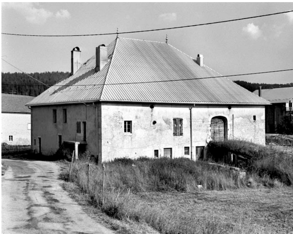
Façade postérieure avec accès aux parties agricoles.
