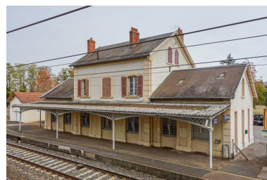
Façade, côté voie ferrée. IVR26_20215800040NUC2A
