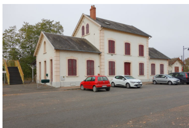
Façade, côté place. Phot. Fabien Dufoulon IVR26_20215800041NUC2A
