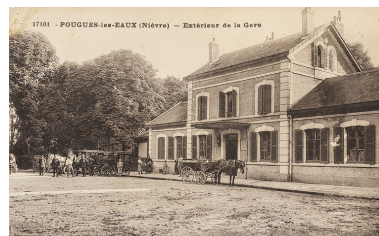
Façade, côté place. Phot. Pierre-Marie Barbe- Richaud, Autr. auteur inconnu IVR26_20205800062NUC2A
