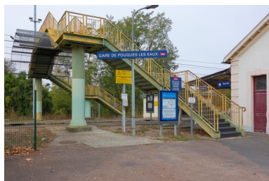
Passerelle au-dessus de la voie ferrée. Phot. Fabien Dufoulon IVR26_20215800039NUC2A
