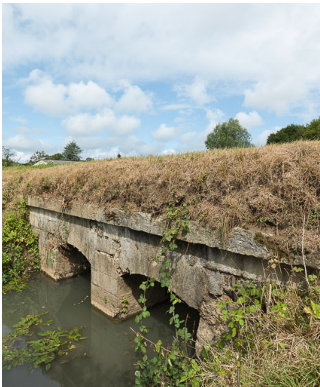
Vue de l'aqueduc.
