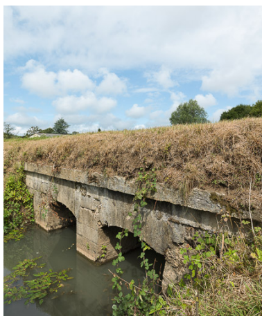
Vue de l'aqueduc. Phot. Pierre-Marie Barbe-Richaud IVR26_20175800235NUC2A
