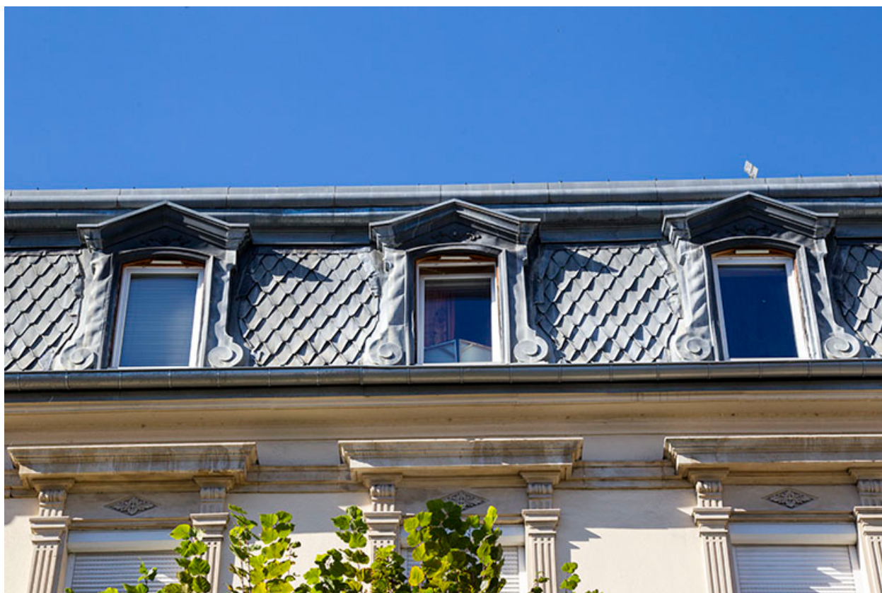
Façade antérieure : baies du brisis.
