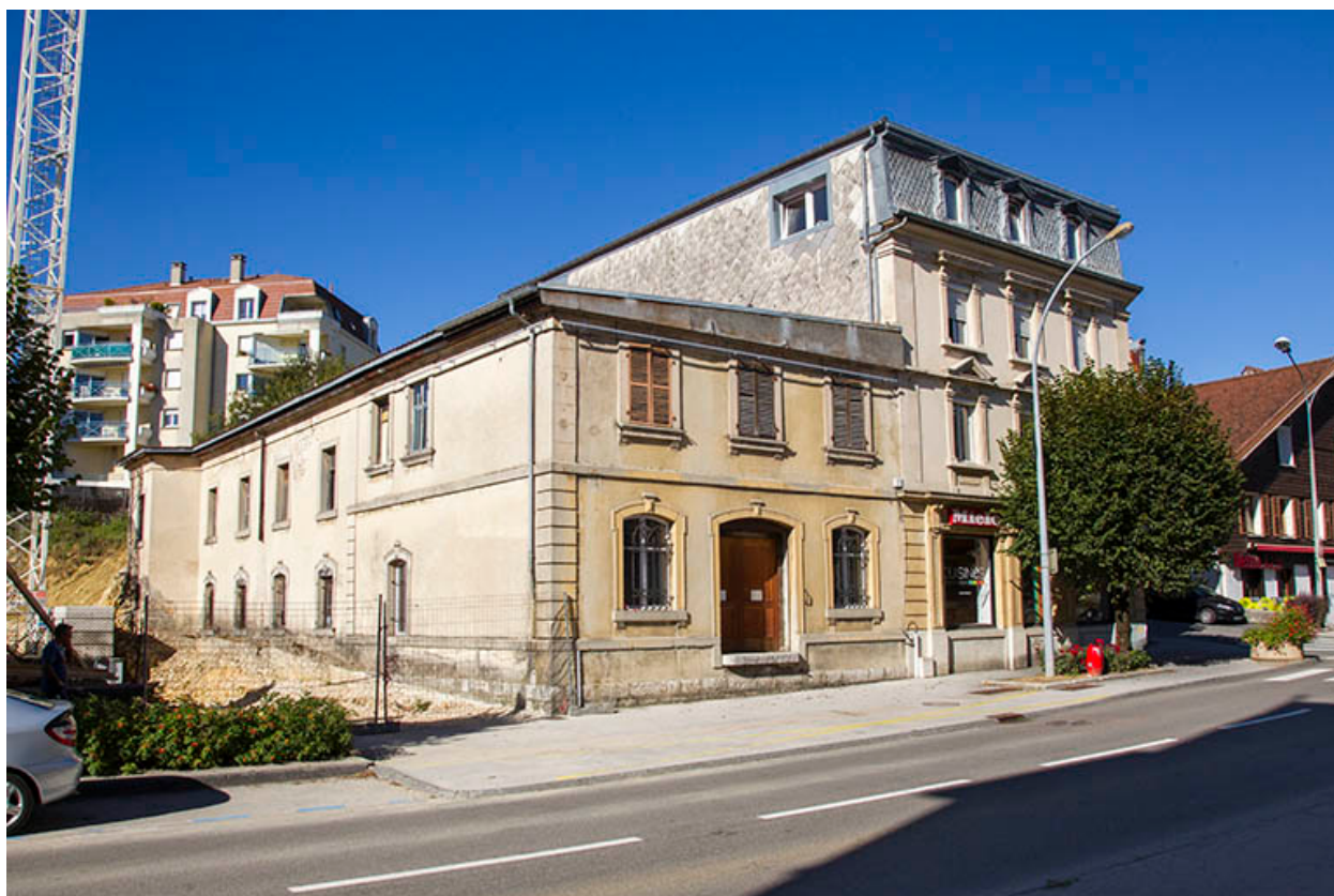
Façades antérieure et latérale gauche.
