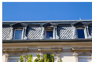
Façade antérieure : baies du brisis. Phot. Yves Sancey IVR43_20132502360NUC2A
