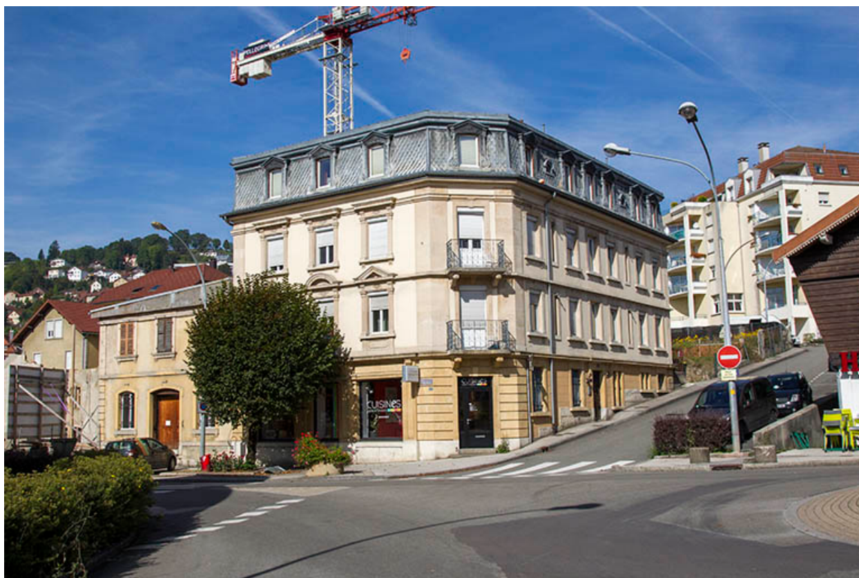
Façades antérieure et latérale droite.
