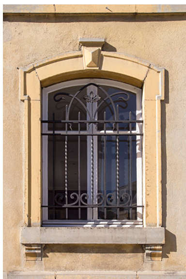
Fenêtre du corps de bâtiment occidental.
