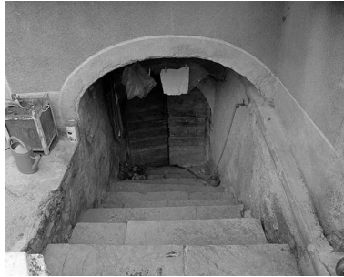
Entrée de la cave. Phot. Yves Sancey IVR43_19813900120X
