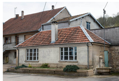
Ancien lavoir transformé en remise. Phot. Jérôme Mongreville IVR43_20187000187NUC4A
