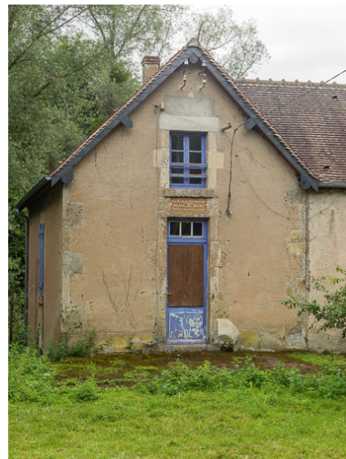
Vue de la maison éclésièr.
