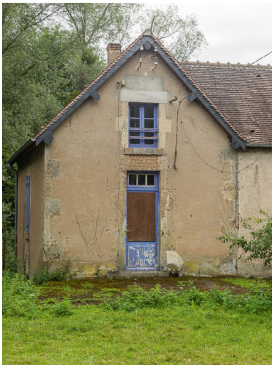
Vue de la maison éclusière.
