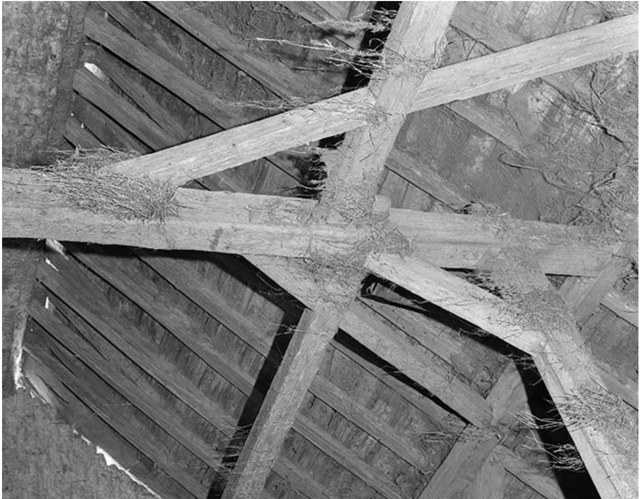
Poteau de charpente latéral d'une ferme.
