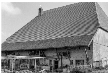
Façade postérieure. Phot. Gilbert Poinot IVR43_19752501351Z
