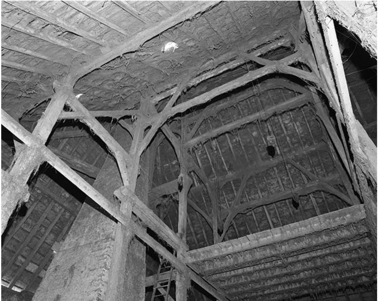
Disposition d'ensemble de la charpente.
