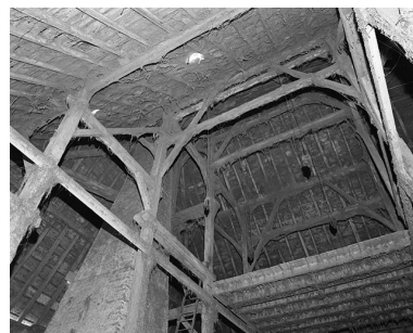
Disposition d'ensemble de la charpente. Phot. Dominique Dominguez IVR43_19792500264X
