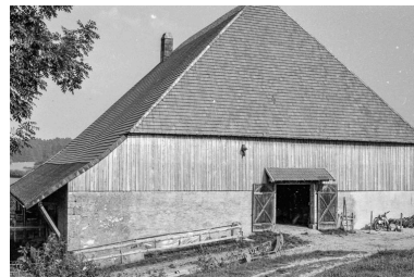
Pignon gauche. Phot. Gilbert Poinot IVR43_19752501350Z
