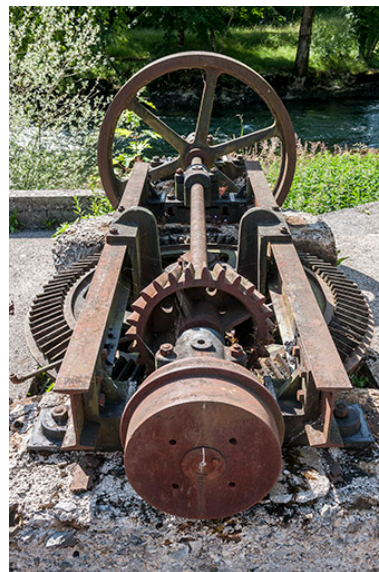
Départ de la transmission de la turbine. Phot. Jérôme Mongreville IVR43_20152501490NUC4A
