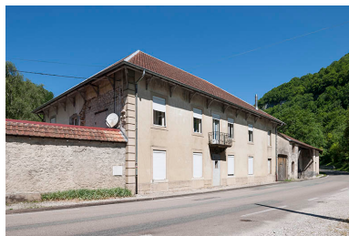
Logement patronal depuis le sud -est. Phot. Jérôme Mongreville IVR43_20152501268NUC4A
