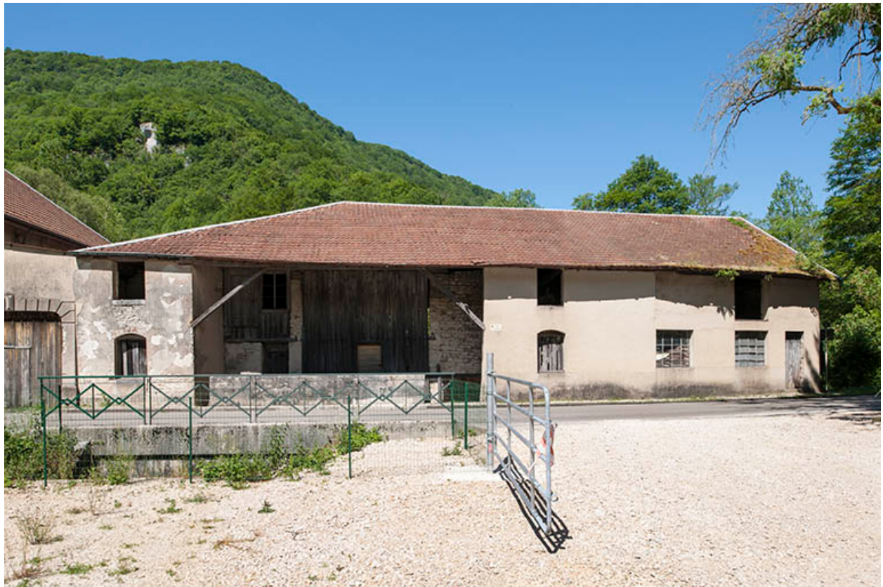
Façade est des écuries et remises.
