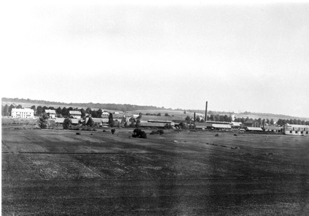
Les Forges de Grandvillars depuis l'ouest.
