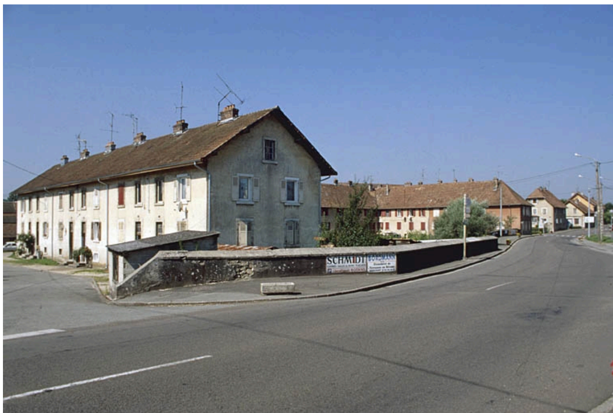
Logements ouvriers depuis l'est.
