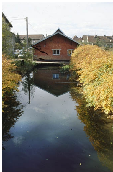
Canal d'aménée. Phot. Yves Sancey IVR43_20009000720ZA
