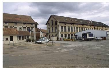
Ateliers de fabrication depuis l'ouest. Phot. Yves Sancey IVR43_20009000700ZA
