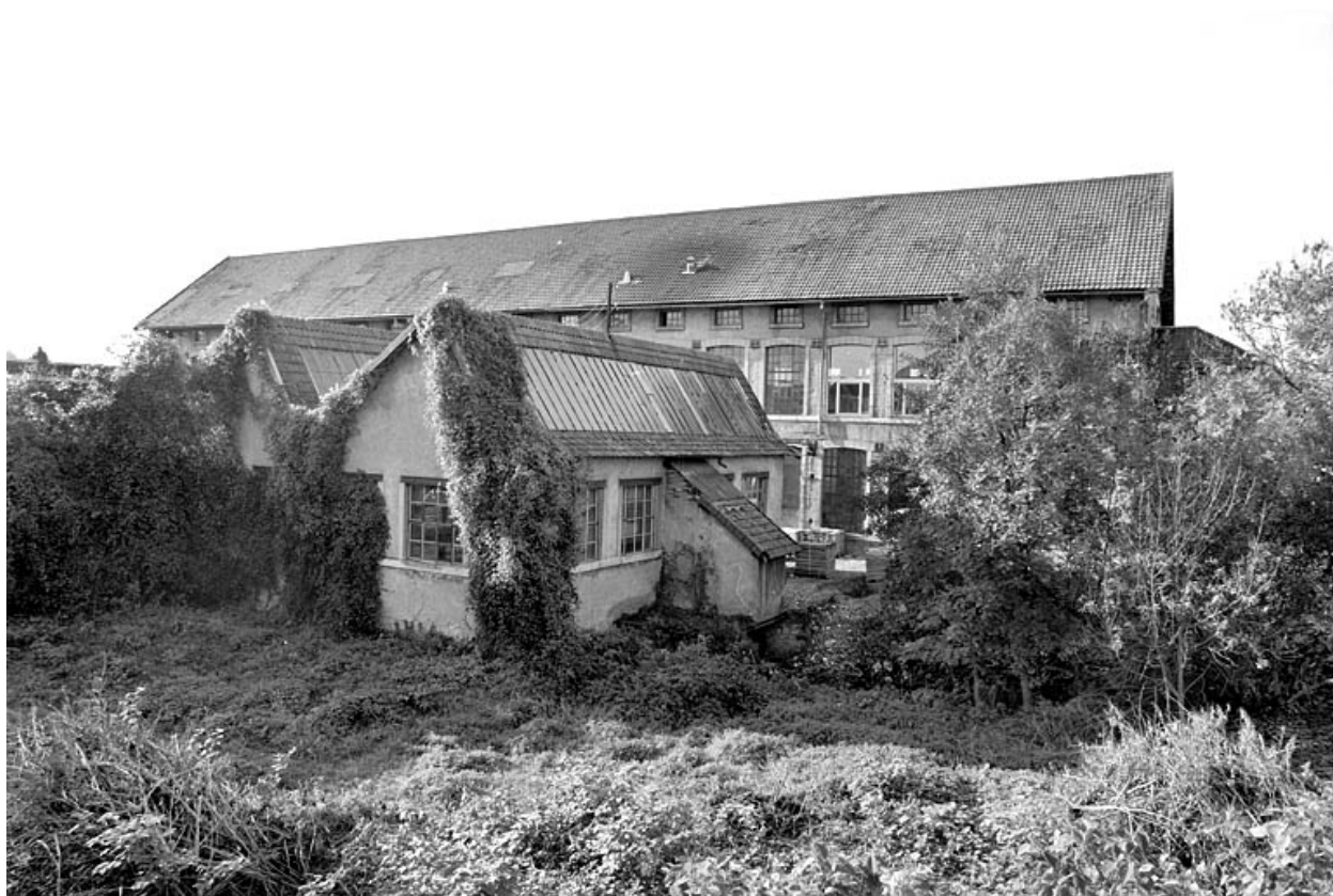
Ateliers de fabrication depuis l'est.
