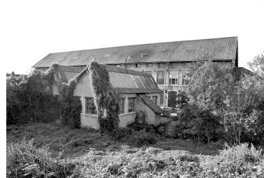
Ateliers de fabrication depuis l'est. Phot. Yves Sancey IVR43_20009000712X
