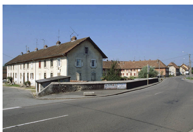
Logements ouvriers depuis l'est. Phot. Yves Sancey IVR43_20019000295ZA
