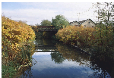
Canal d'aménée depuis l'aval. Phot. Yves Sancey IVR43_20009000724ZA
