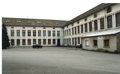
Ateliers de fabrication en L sur la cour. Phot. Yves Sancey IVR43_20009000686ZA
