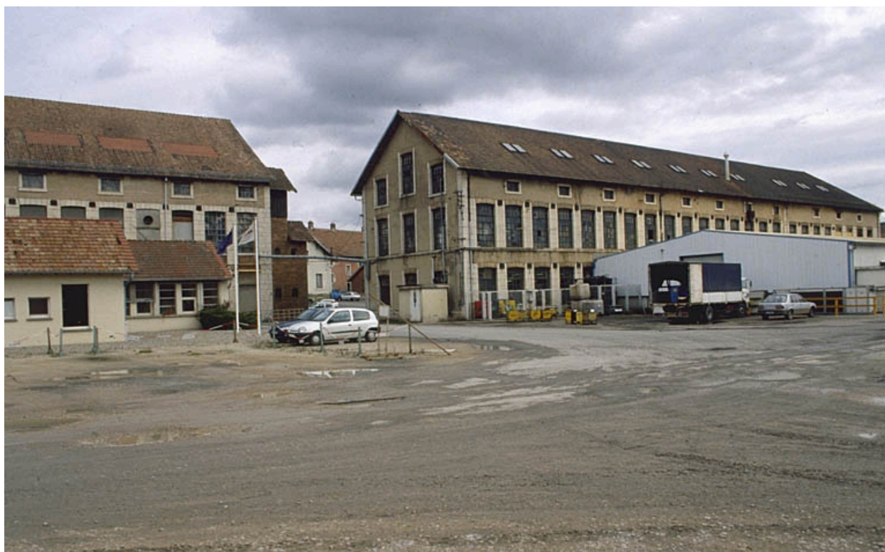
Ateliers de fabrication depuis l'ouest.
