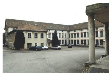
La cour de l'usine depuis l'entrée. Phot. Yves Sancey IVR43_20009000684ZA
