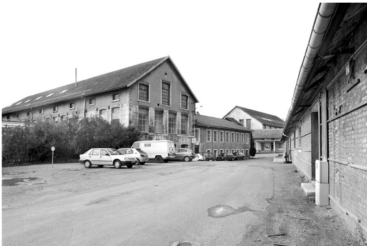
Atelier de fabrication et bureau depuis l'est.
