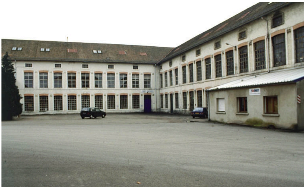
Ateliers de fabrication en L sur la cour.
