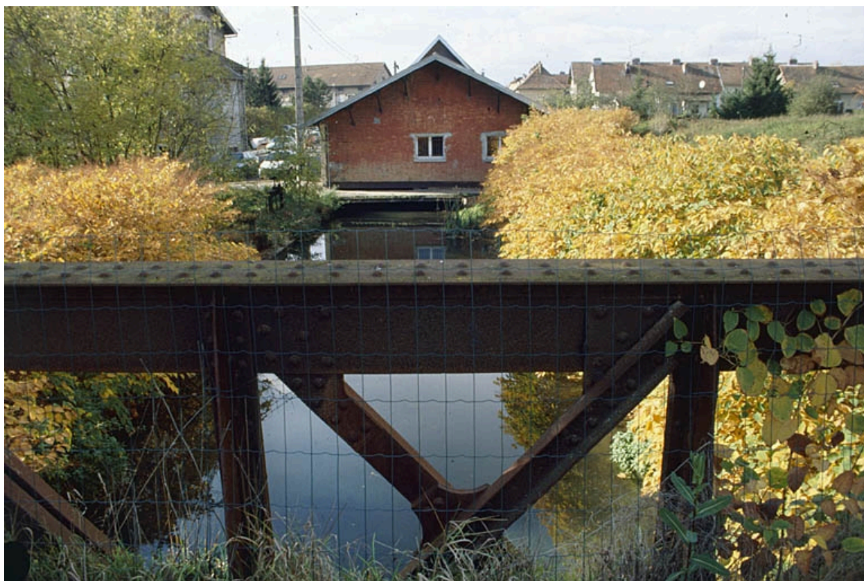
Passerelle sur le canal d'amenée.
