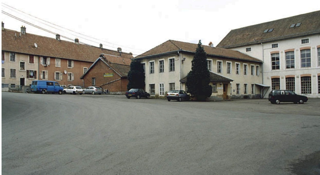
Logement ouvrier et bureau depuis la cour.
