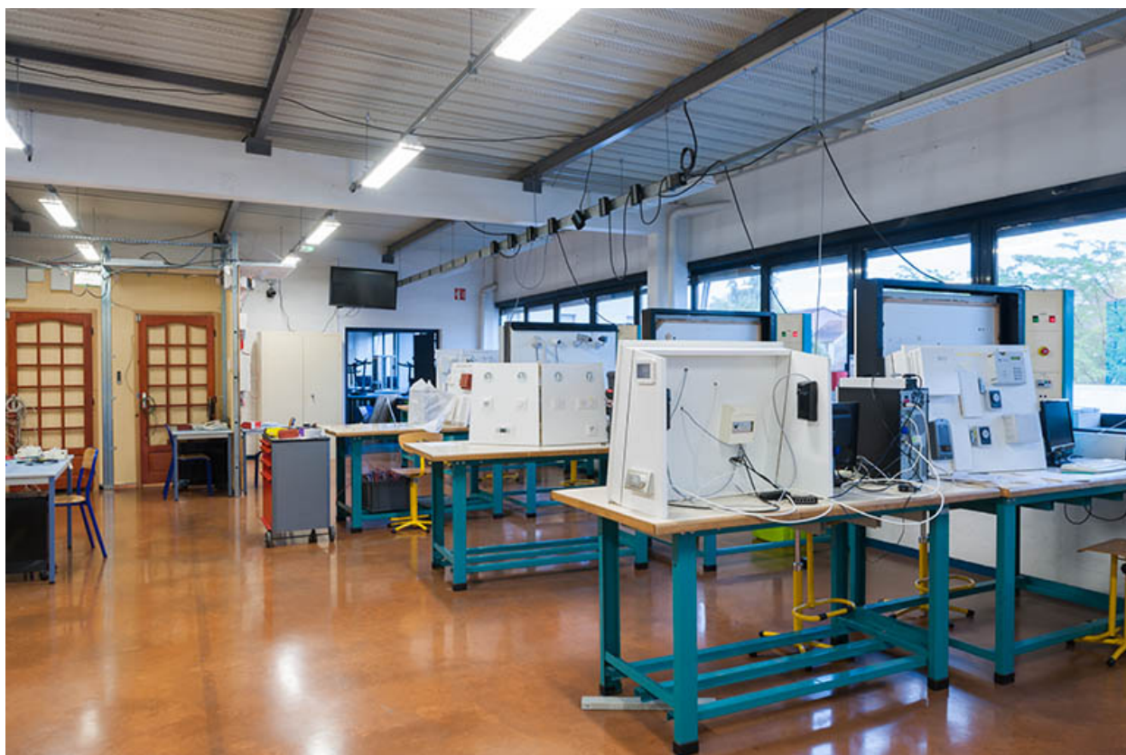
Dans l'atelier froid, climatisation et domotique.
