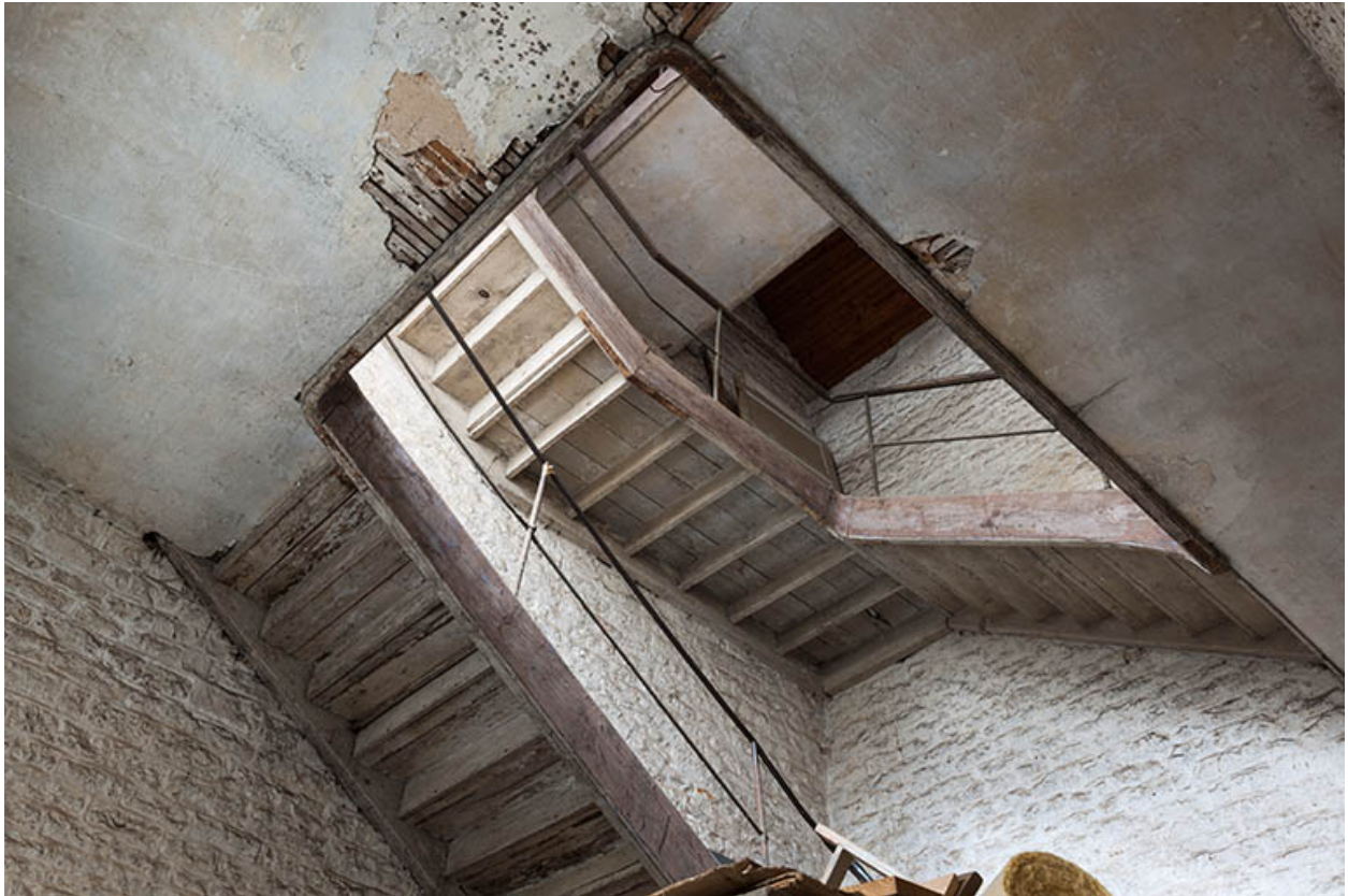
Escalier dans l'atelier des agents.
