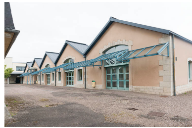
Façade sur cour de la cantine. Phot. Mary Ruffinoni IVR43_20137000571NUC4A
