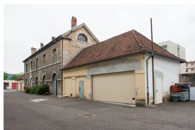
Angle nord-est de l'atelier des agents. Phot. Mary Ruffinoni IVR43_20137000576NUC4A
