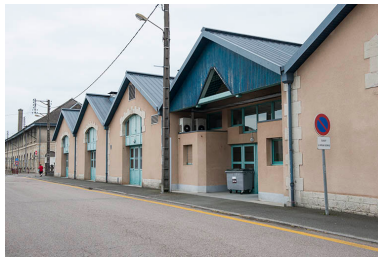
Façade nord de la cantine. Phot. Mary Ruffinoni IVR43_20137000580NUC4A
