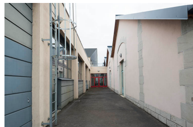
Entre l'atelier structure métallique et plasturgie. Phot. Mary Ruffinoni IVR43_20137000579NUC4A
