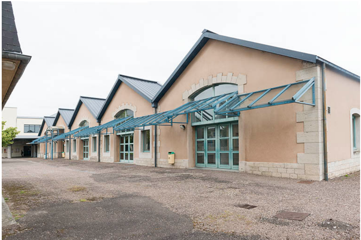
Façade sur cour de la cantine.
