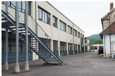
Façade ouest de l'externat. Phot. Mary Ruffinoni IVR43_20137000575NUC4A
