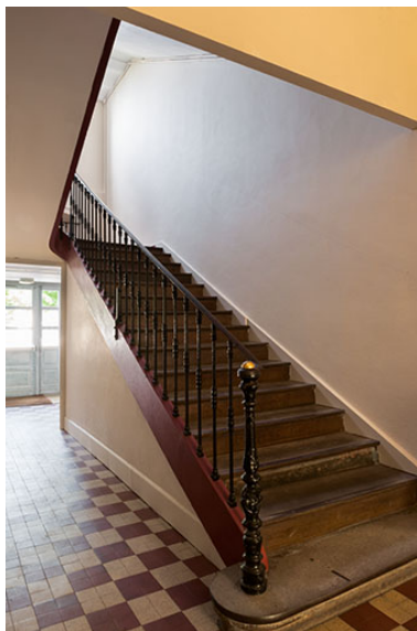
Escalier de l'administration-internat. Phot. Jérôme Mongreville IVR43_20137000611NUC4A
