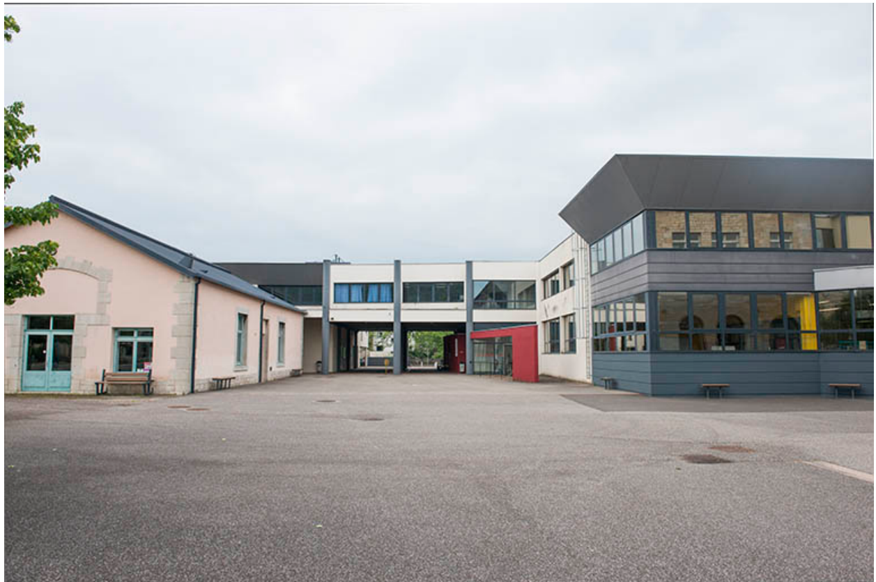
Façade postérieure de l'entrée, ateliers.
