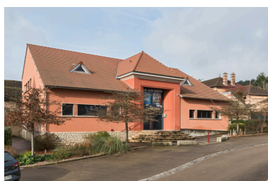
Vue d'ensemble, de trois quarts gauche. Phot. Pierre-Marie Barbe-Richaud IVR26_20238900298NUC2A
