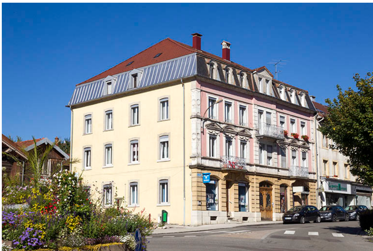
Façades antérieure et latérale gauche.
