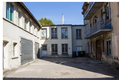
Cour et corps de bâtiment latéral. Phot. Yves Sancey IVR43_20132502187NUC2A
