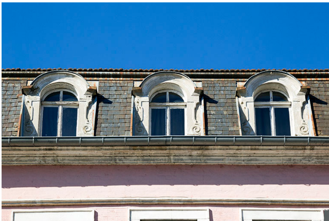
Façade antérieure : lucarnes.
